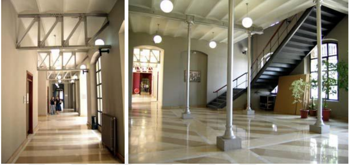
Görsel 4.10. Özgün taşıyıcıların açıkta bırakıldığı mekanlar (Selçuk, 2006, s. 94)
