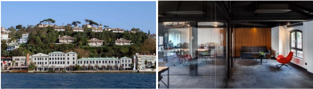
Görsel 3.19. Actera Ofis yapısı ve iç mekanı (http-31)
