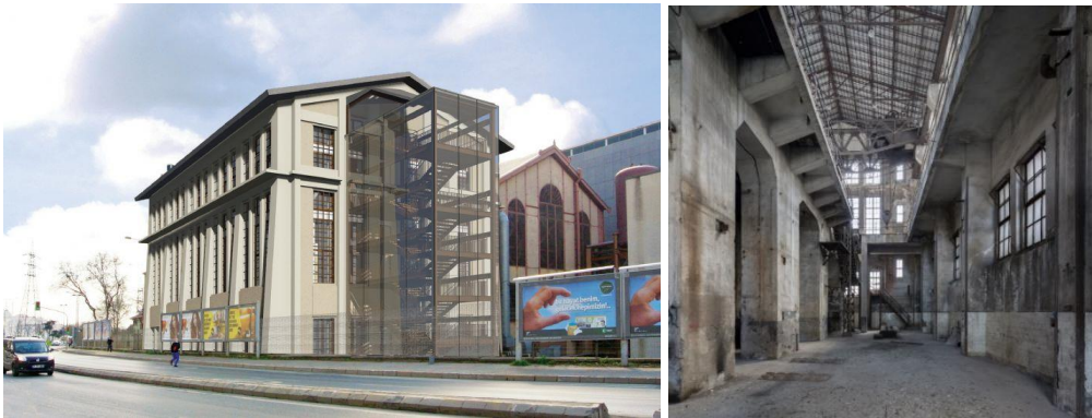
Görsel 4.25. Seyfi Arkan tarafından tasarlanan makine dairesi yapısı ( http-53 )
