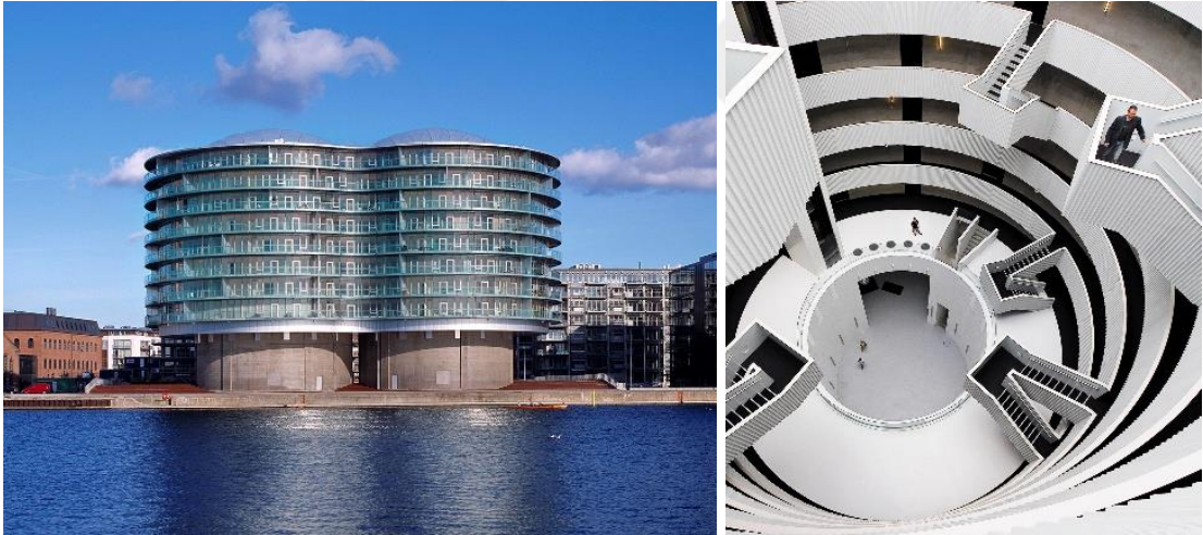
Görsel 3.9. Gemini Rezidans yapısı ve iç avlu ( http-13 )
