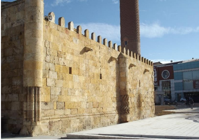
Resim 5.16. Cacabey Medresesi batı cephesi
