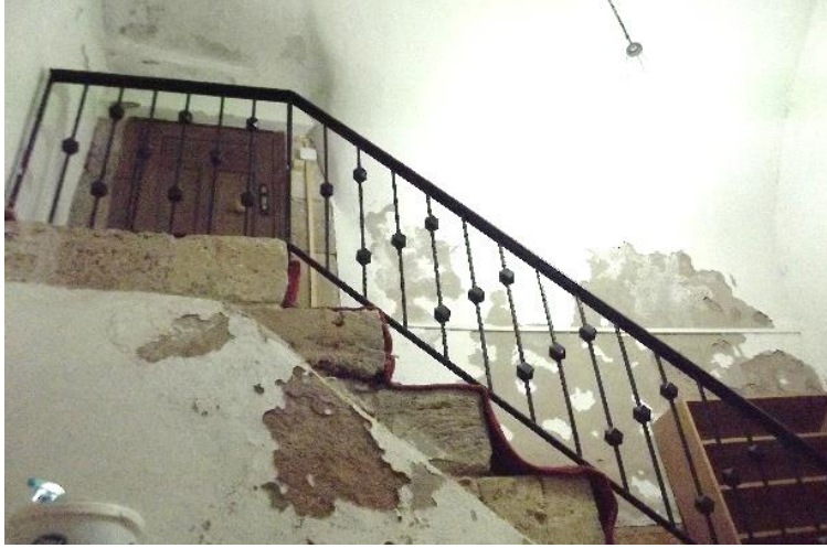
Resim 5.13. Mahfil katına çıkan merdiven
