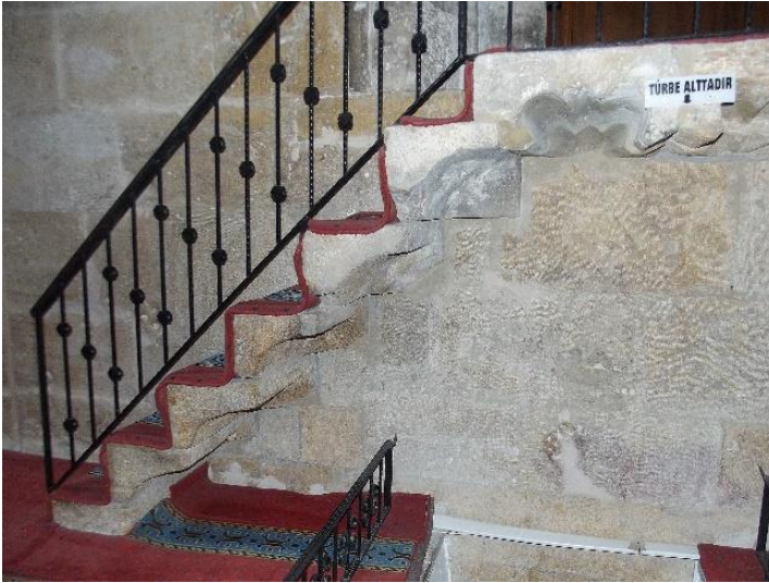
Resim 5.6. Kümbetin orta bölümüne çıkan merdiven
