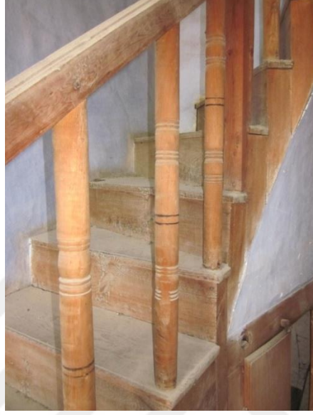
Şekil 4.69: 105 nolu oda dönel merdiven korkuluğu, 2019.
