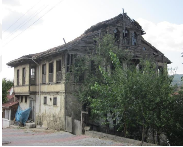
Şekil 4.57: Sokaktan yapıya bakış, 2018.
