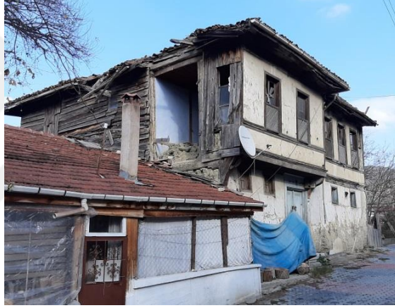
Şekil 4.63: Ocak kaldırıldıktan sonra batı cephesi, 2019.
