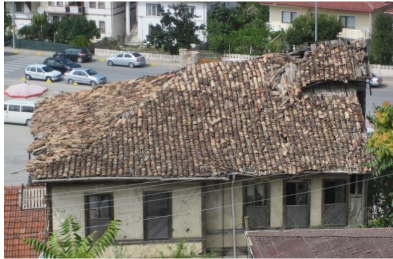
Şekil 4.70: Çatı form ve malzemesi, 2019.
