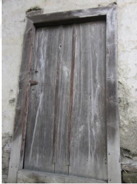
Şekil 4.59: Bodrum giriş kapısı, 2018.
