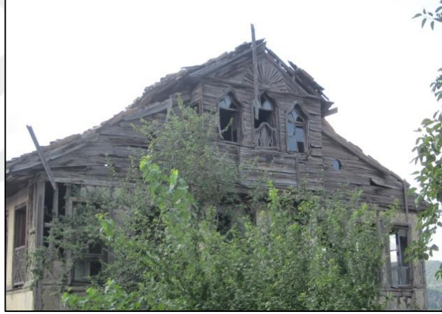
Şekil 4.55: Çatı katı görünümü, 2019.
