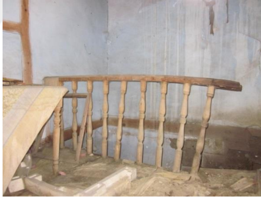
Şekil 4.29: 1. kat sofası merdiven parapeti, 2019.
