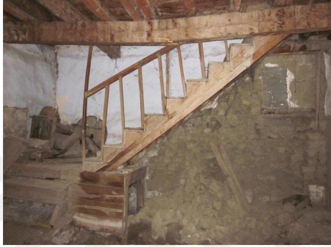
Şekil 4.20: Bodrum kat merdiveni, 2018.
