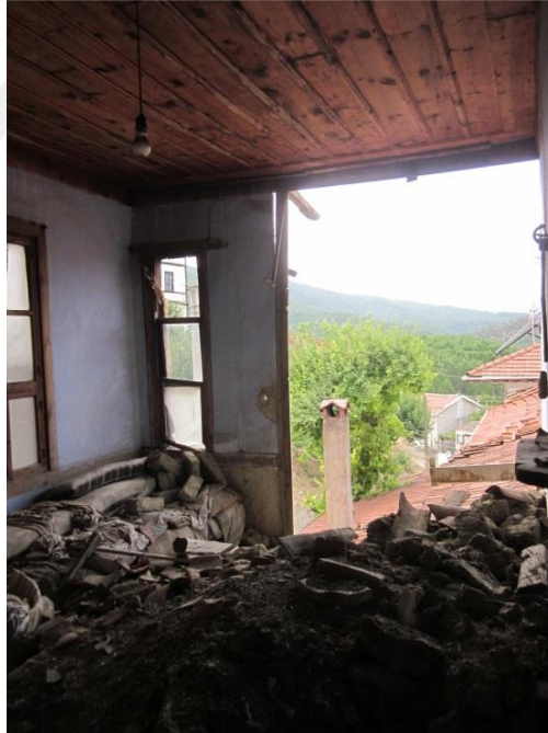
Şekil 4.45: Ocak kaldırıldıktan sonra, 2019.
