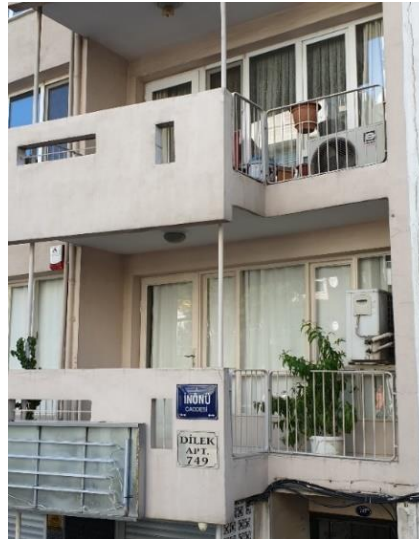
řekil 5. 15. Dilek Apartmanı balkon geniřlięi
