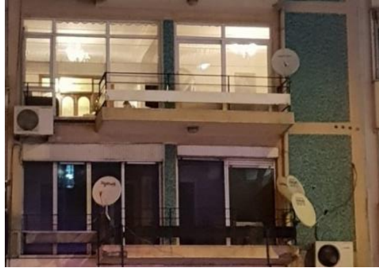
Şekil 3. 37. Filiz Apartmanı, Güzelyalı, İzmir, şeffaf cephe organizasyonu
