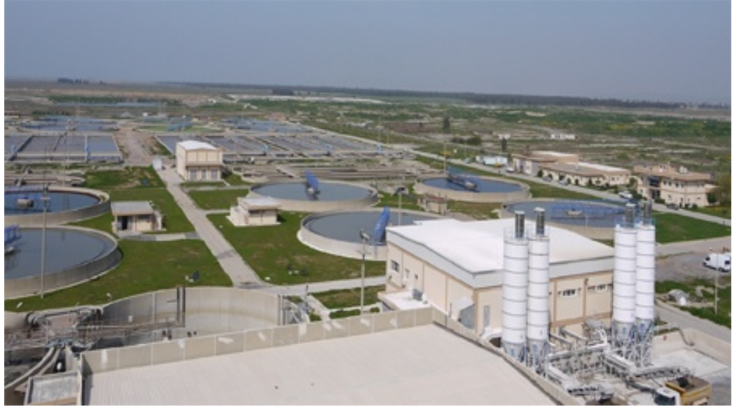
Resim 3 . 1: Çiğli Atıksu Arıtma Tesisinin Genel Görünümü
