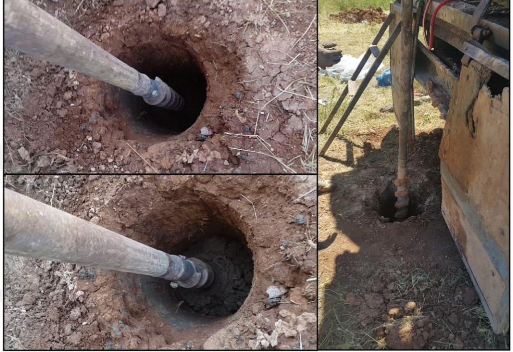
Şekil 3.21. Arazi şartlarında DKK üretimi
