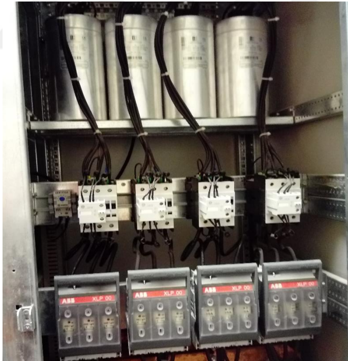
Şekil 3.5 : Reaktif güç üretimindeki kullanılan sigortalar.
