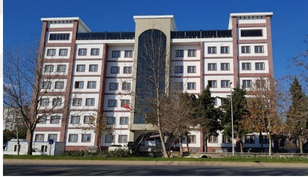
Şekil 6.1 : Tesisin genel görünümü (12.12.2018).
