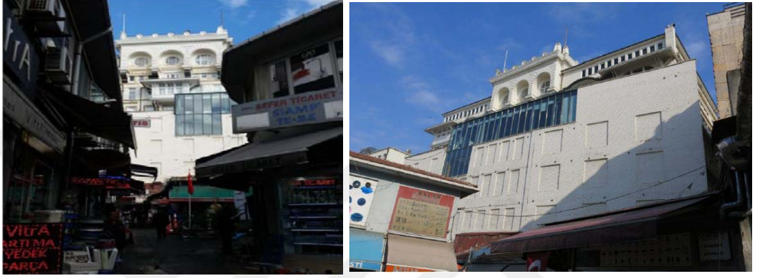
Şekil 73. Yapının Güney Cephesinden Ek Yapının Görünümü
