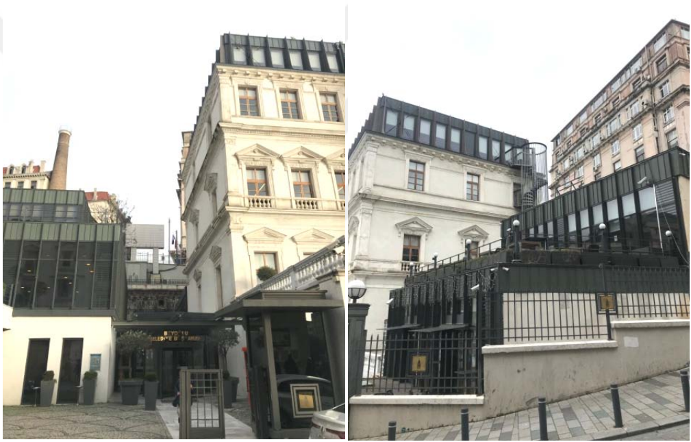
Şekil 60. Beyoğlu Belediye Binası Ek Yapıları
