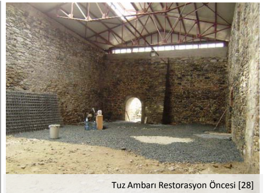
Tuz Ambarı Restorasyon Öncesi [28]
