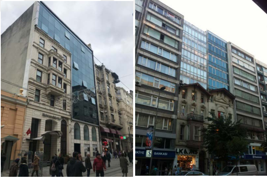
Şekil 128. Osmanbey Tarihi Yapı İlave Kat Uygulamaları
