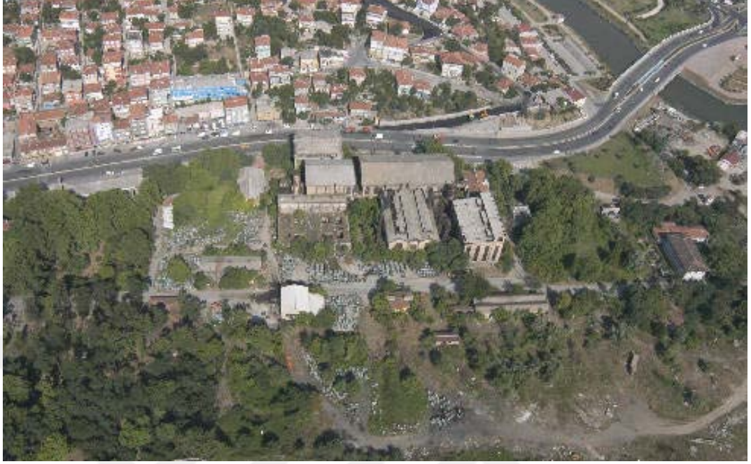
Şekil 46. Restorasyon Öncesi Silahtarağa Elektrik Santrali (url-36)
