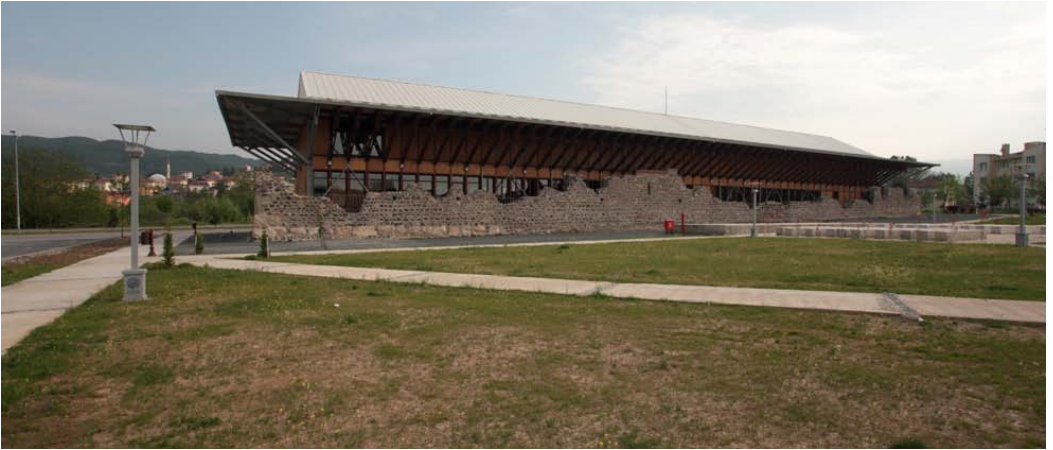
Şekil 99. Kazıklı Kervansarayı Kültür Merkezi (Restorasyon Sonrası) (url-47)
