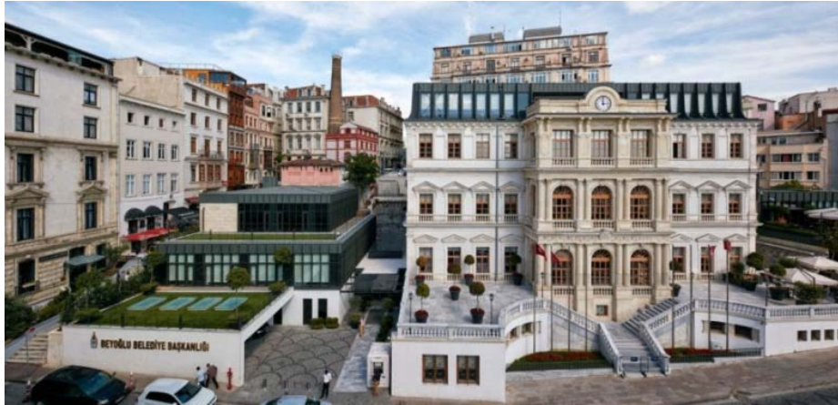
Şekil 58. Restorasyon Sonrası Beyoğlu Belediye Kompleksi (url-40)
