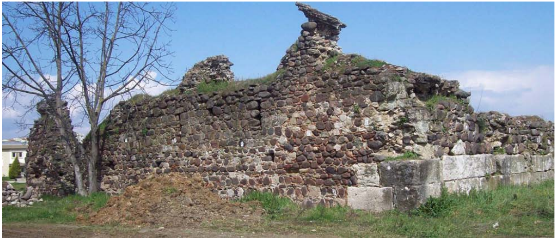
Şekil 94. Kazıklı Kervansarayı Restorasyon Öncesi (url-47)
