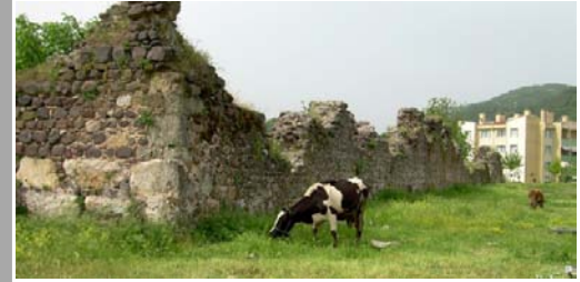
Kazıklı Kervansarayı Restorasyon Öncesi[11]
