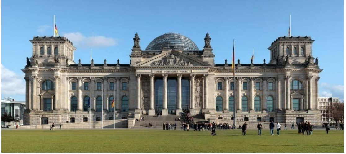
Şekil 141. Alman Parlamento Binası Güncel Görünüm (url-61)
