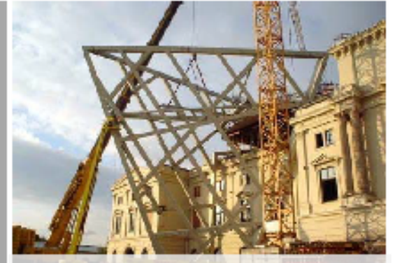
Ek Yapım Aşaması[29]
