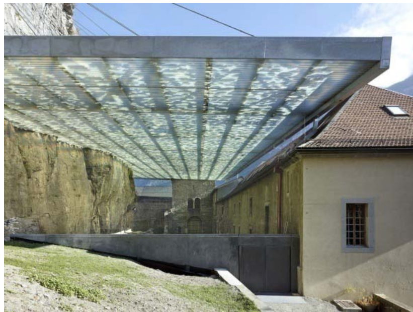
Şekil 194. Saint Maurice Manastırı Koruma Çatısı (url-83)
