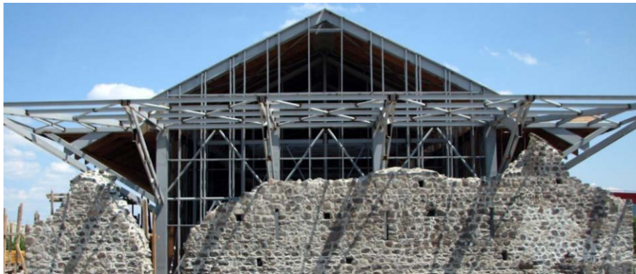
Şekil 96. Kazıklı Kervansarayı Restorasyon Aşamaları (url-47)
