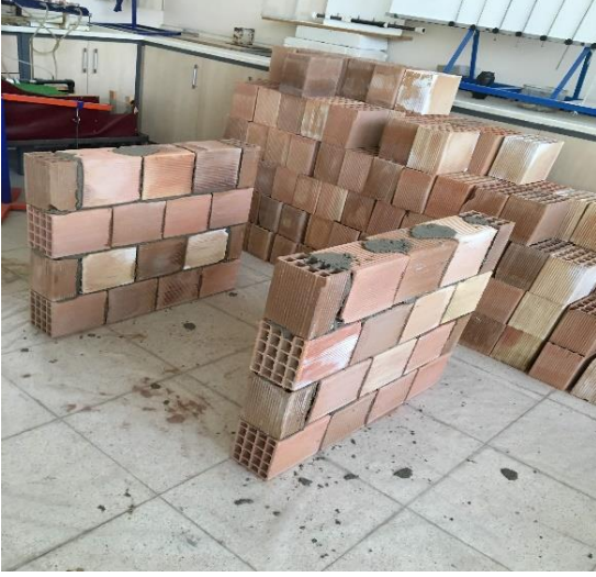
Resim 4.13.b) Tuğla duvarların örülmesi
