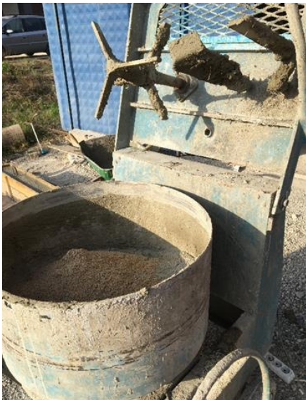
Resim 4.7. Miksere malzemelerin yerleştirilmesi
