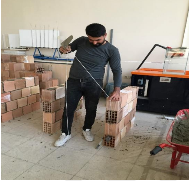
Resim 4.14. Tuğla duvarlar örülürken şakulle kontrol edilmesi
