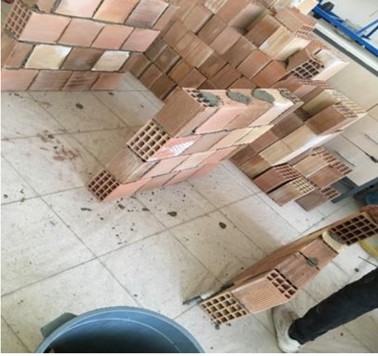
Resim 4.13.c) Tuğla duvarların örülmesi
