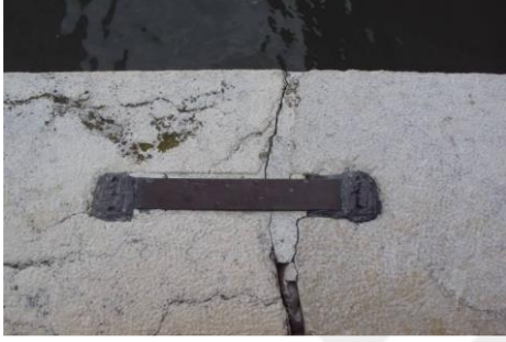
Resim 3.19. Metal bağlantı elemanın numuneye uygulanması (Koçak, 2013)
