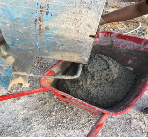
Resim 4.8. Hazırlanan derz harcının el arabasıyla taşınması
