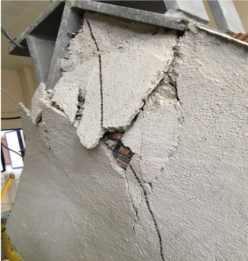
Resim 5.47. c) Diagonal yükleme sonrası çift yüzü Tür 2 ile güçlendirilmiş 1. tuğla duvar numunesinin arka yüzü
