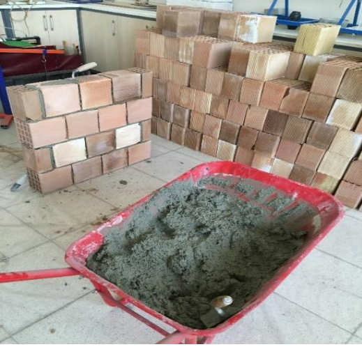
Resim 4.13.a) Tuğla duvarların örülmesi
