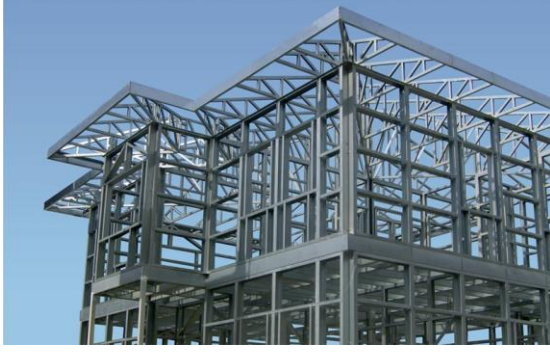
Resim 2.1. Çelik iskeletli yapı, ( https://www.erkiz.com.tr/celik-yapilar/ )
