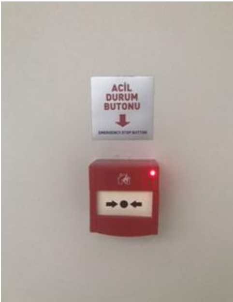
Şekil.24. Yangın İhbar Butonu
