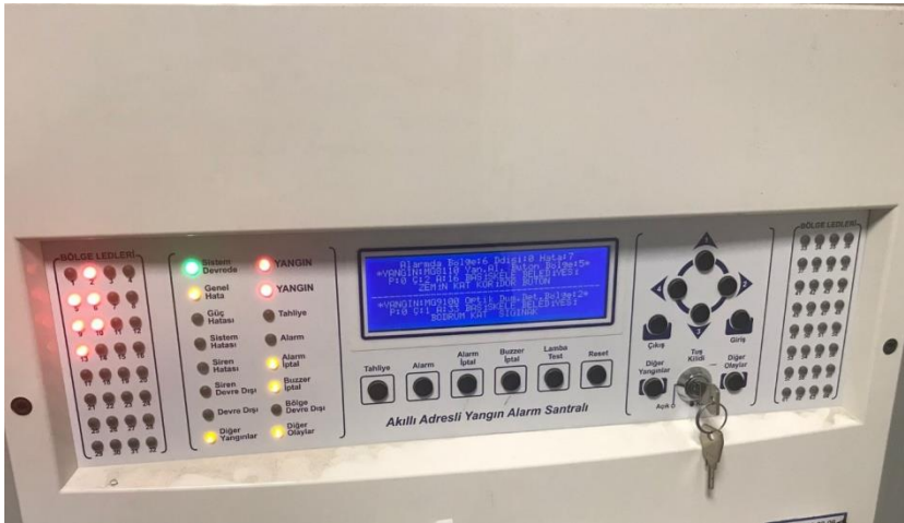
Şekil.26. Adresli Yangın Alarm Sistemi
