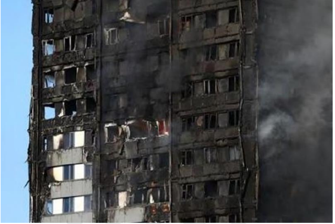
Şekil.9. Yüksek Bir Binada Elektrik Arızasından Çıkan Yangın
