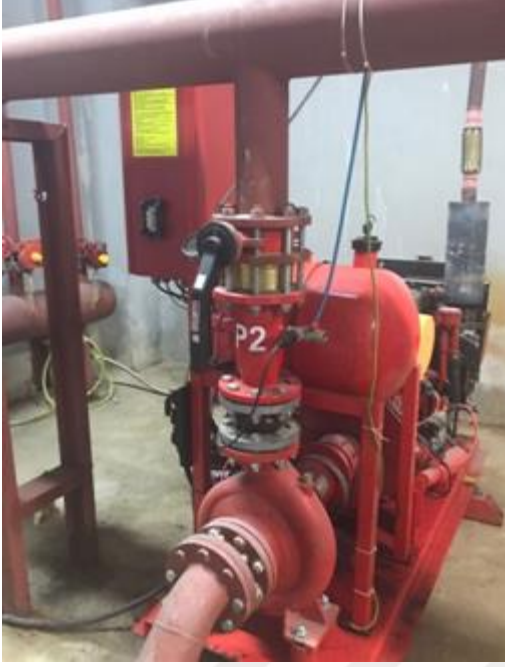
Şekil.13. Dizel Pompa
