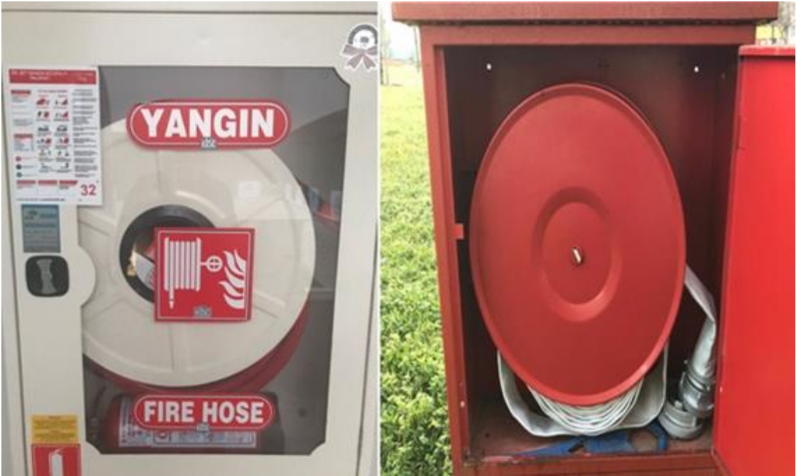
Şekil.18. Yangın Dolabı
