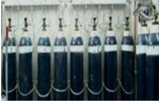
Şekil.3. Oksijen Tüpleri ve Oksijen Tankı
