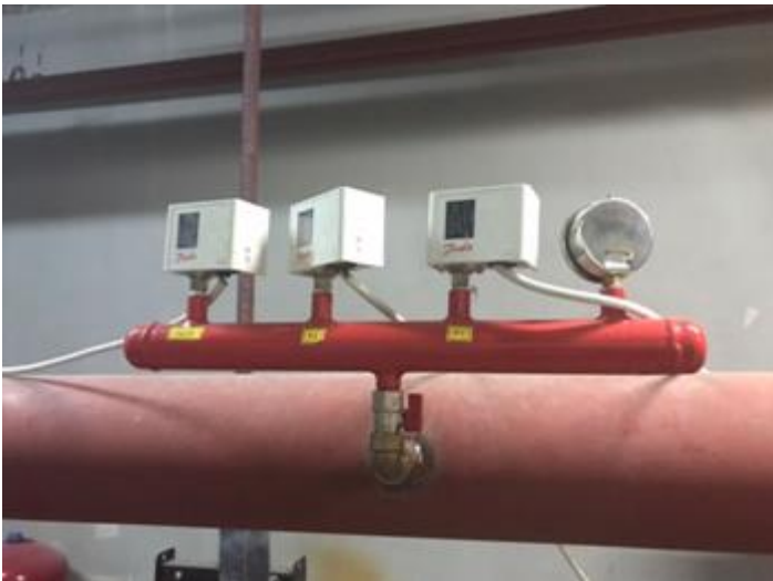
Şekil.16. Basınç şalterleri
