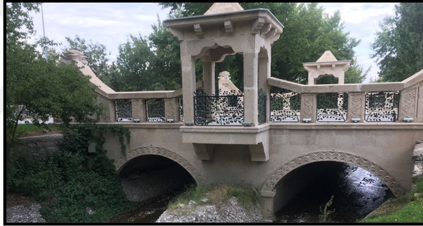
Şekil 5.5. Köfke Taşı Köprü Uygulaması, Isparta (Yüksel, 2018)
