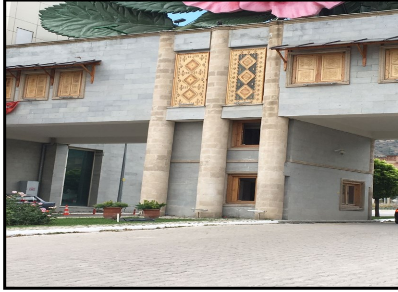
Şekil 5.4. Geyran Taşı (Andezit) Duvar Kaplaması ve Köfke Taşı Sütun Uygulaması, Isparta (Yüksel, 2018)
