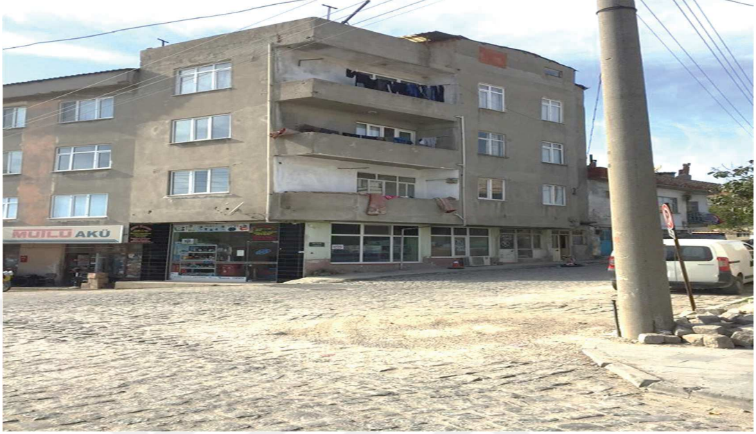
Şekil 7. Ayvacık ilçesinde üç katında da Suriyeli sığınmacıların oturduğu bir bina (2017)
