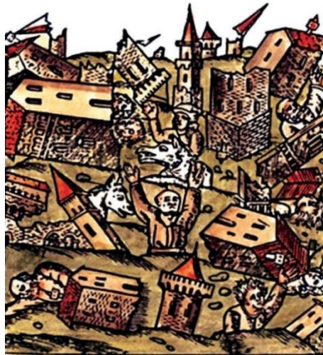
Şekil 2.9: 1509 İstanbul Depremi, ahşap kalıp desen.
