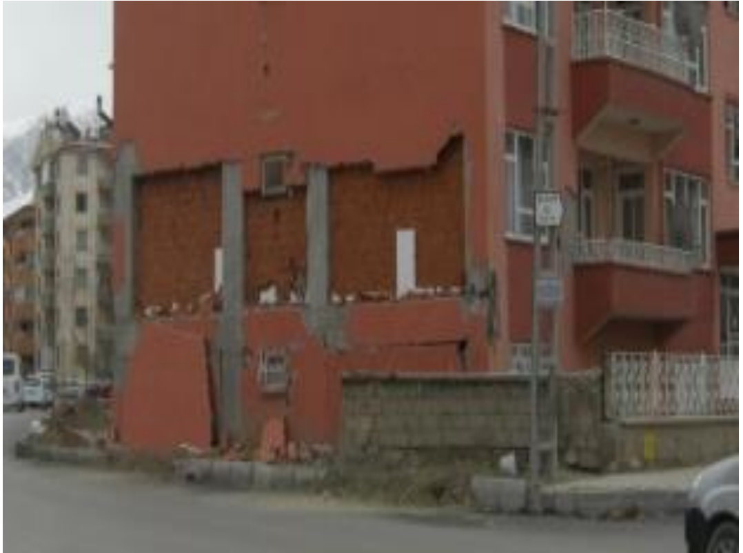
Şekil 2.23 : Taşıyıcı olmayan yapı elemanlarının kullanımı ile ilgili gözlemler.
