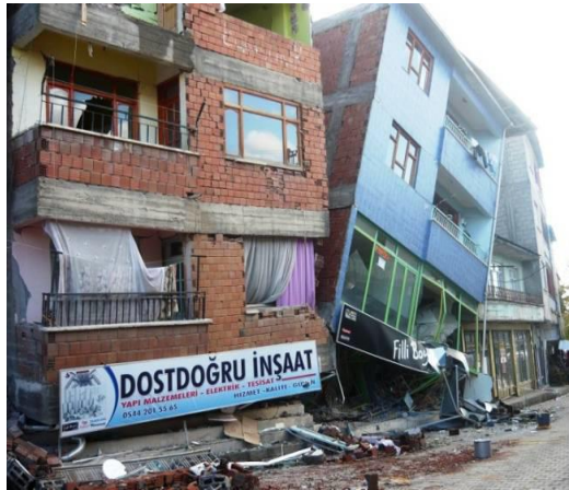
Şekil 2.19: Yumuşak ve/veya Zayıf Kat Düzensizlikleri ile İlgili Gözlemler.
