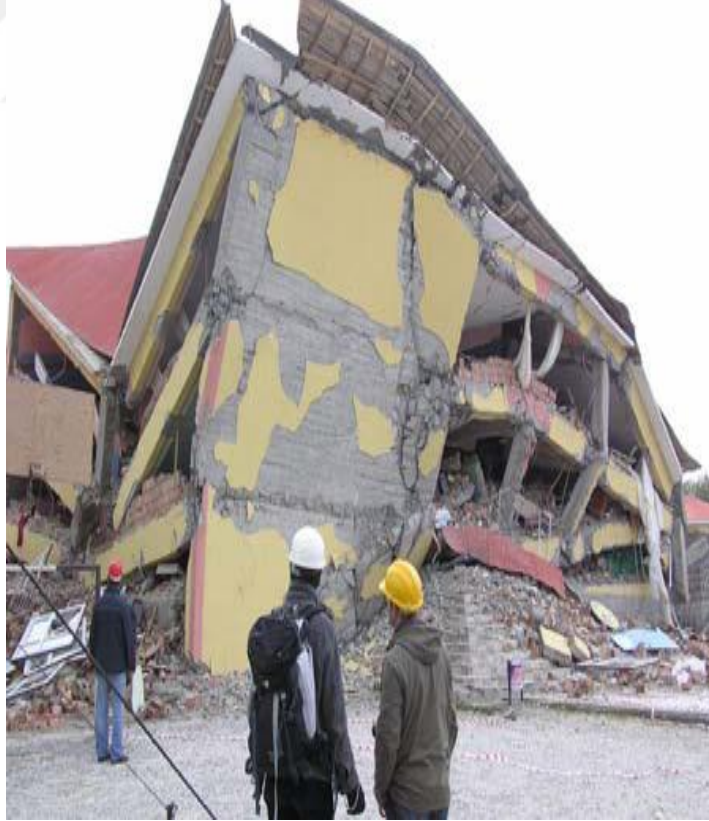
Şekil 2.22 : Taşıyıcı sistem tasarımında perdeler ve yanal rijitliğin yetersizliği ile ilgili gözlemler.
