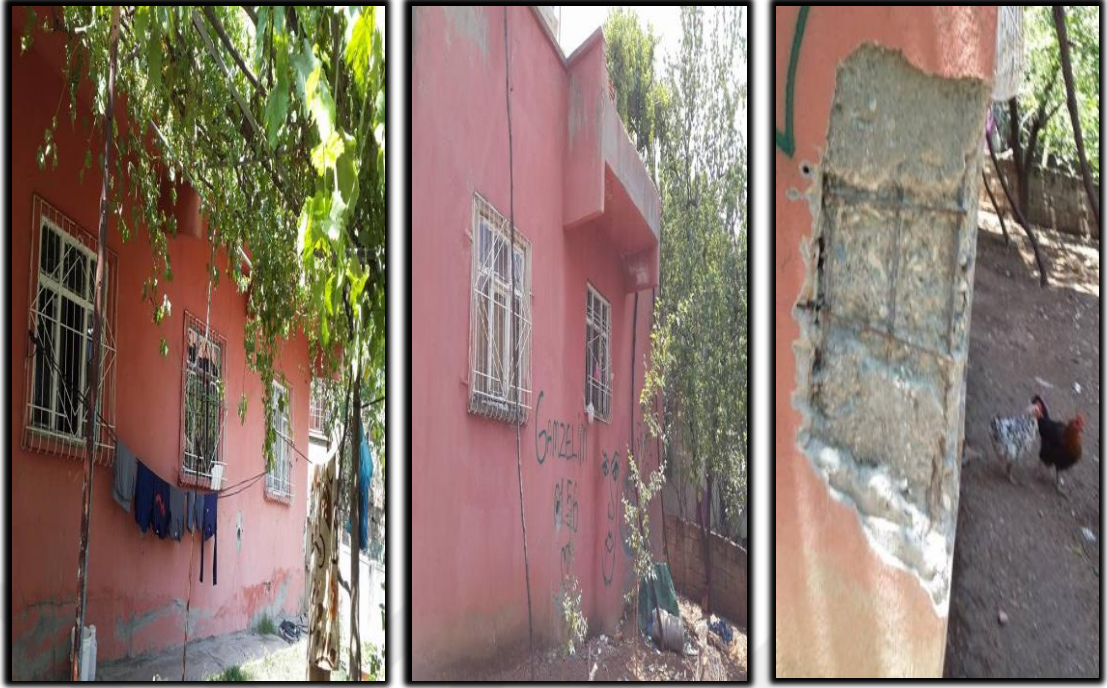
Şekil 3.4. a Ön Cephe (a), Yan Cephe(b), Kolon Sıyrma(c) görüntüleri
