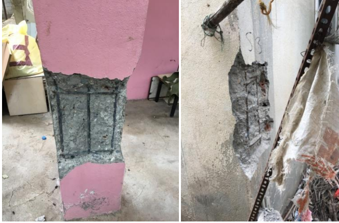
Şekil 3.31. Kolon sıyrma görüntüleri
