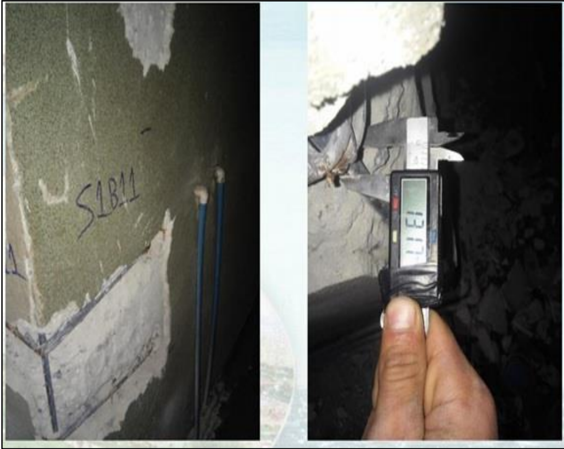
Şekil 2.11. Kolonun iki kenarı boyunca sıyırma yapılması ve donatı çapının belirlenmesi
