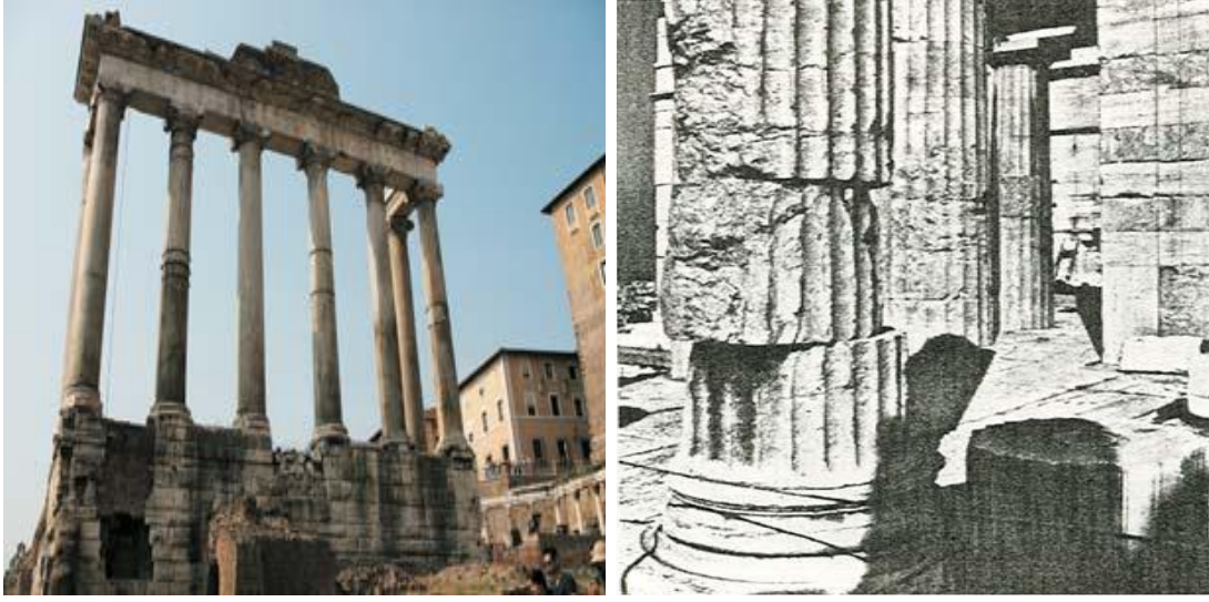
Şekil 4.9. Sütunlar, (a) tek parça sütunlar (Roma tipi), (b) Çok parçalı sütunlar (Sesigür, 2007 )
