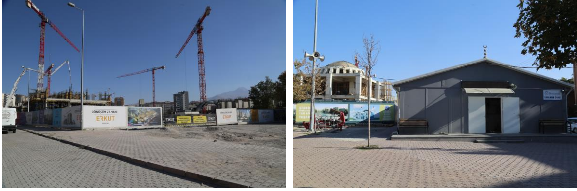
Şekil 5. 17. Sahabiye Mahallesi Kentsel Dönüşüm Alanı 1. Etap yapım aşamalarından görüntüler (Özgün, 2018)
