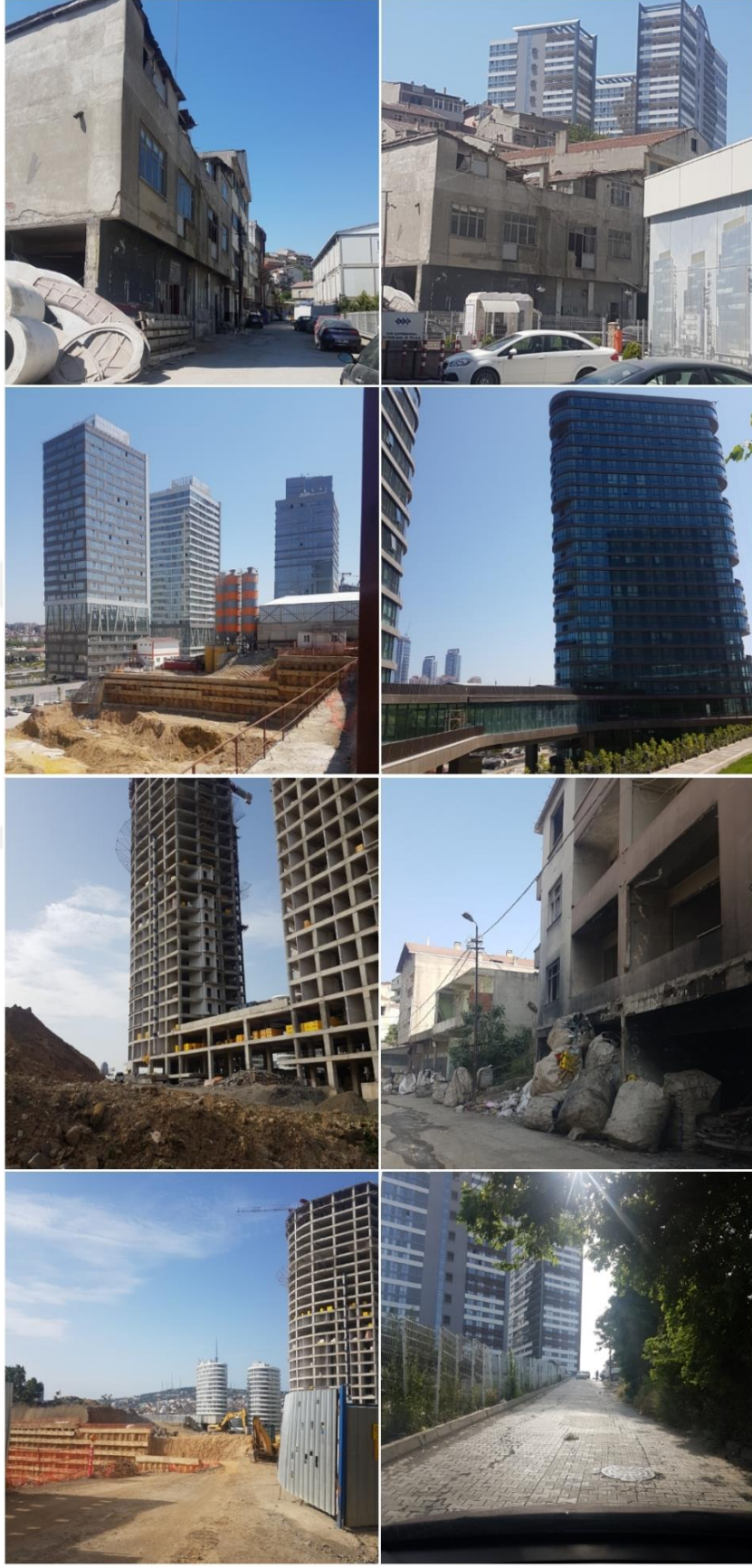
Şekil 3.46 Fikirtepe Bölgesindeki Güncel Durum I, 2018.
