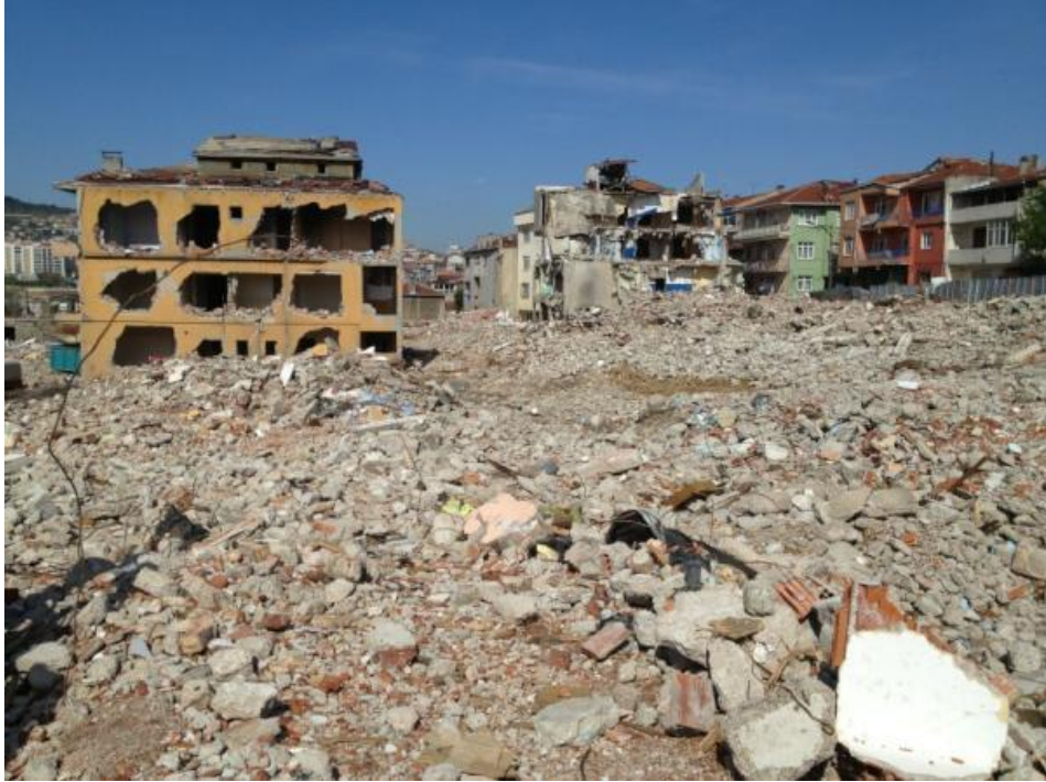
Şekil 3.29 Fikirtepe’de Yıkımı Tamamlanmış Adalardan Görüntüler II 56
