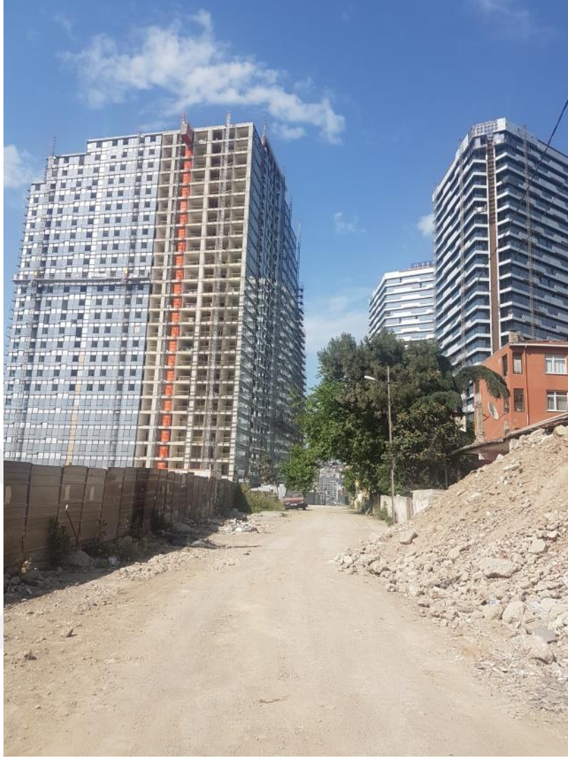
Şekil 3.33 Fikirtepe Kentsel dönüşüm uygulamaları saha incelemesi II (Mayıs,2018).
