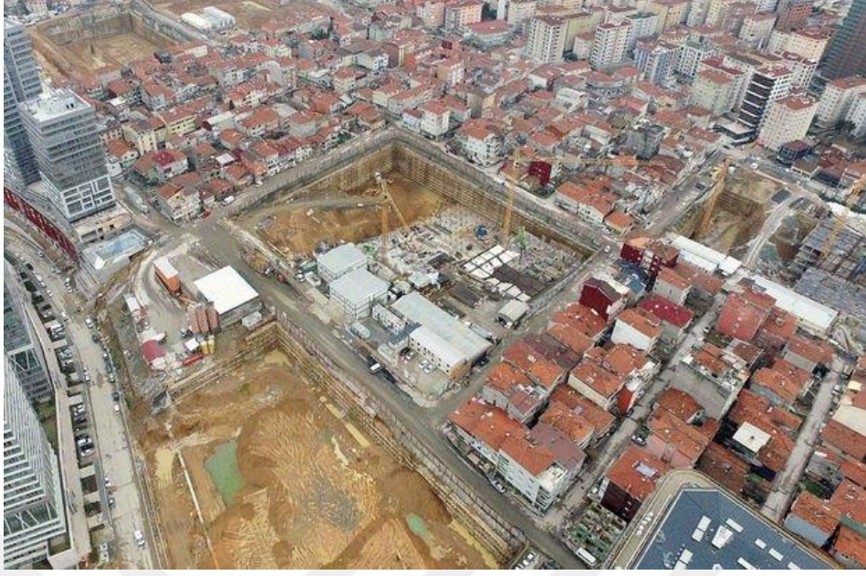
Şekil 3.28 Fikirtepe’de Yıkımı Tamamlanmış Adalardan Görüntüler 55
