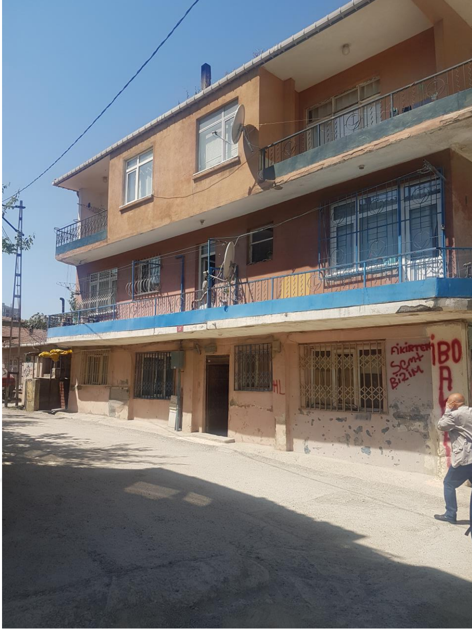
Şekil 3.40 Fikirtepe’deki Bakımsız Binalar, 2018.
