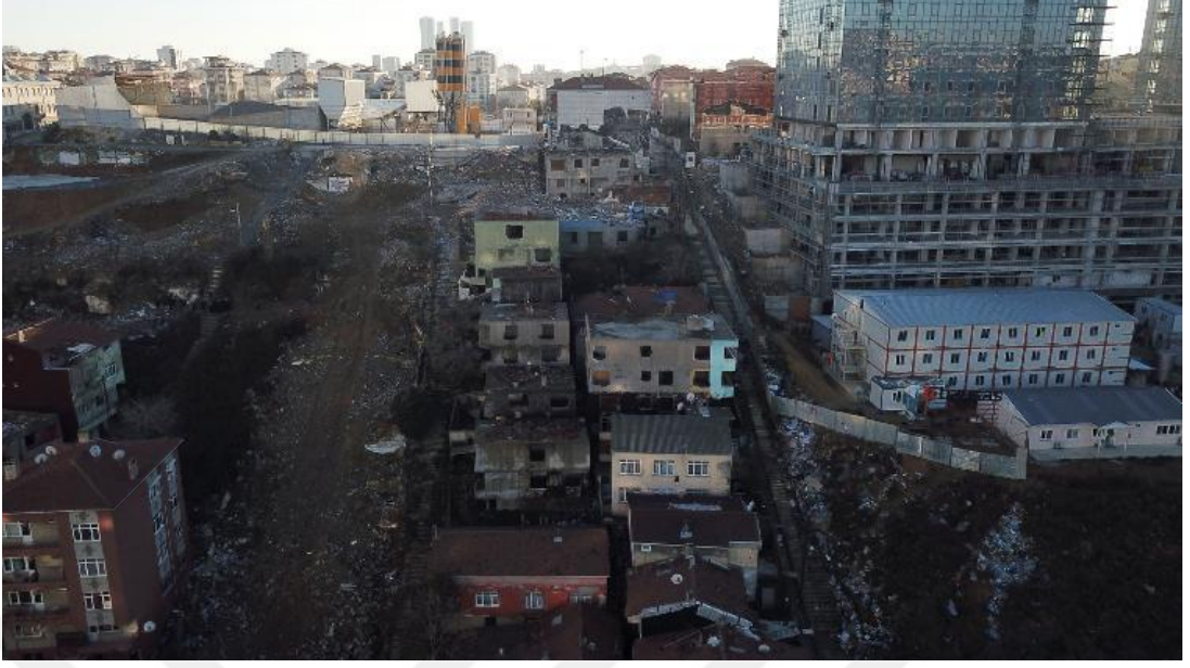
Şekil 3.10 Fikirtepe Alanı Eğimli Yapısı
