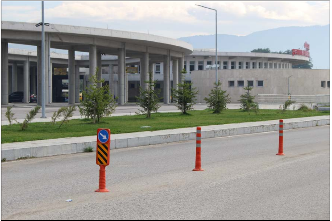
Şekil 3.30. Düzce otobüs terminali (25.09.2017).
