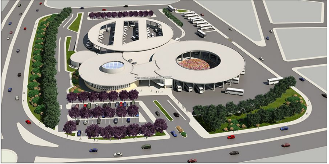
Şekil 3.29. Düzce otobüs terminali [107].
