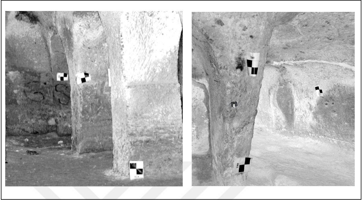
Şekil 4.7. Hedef levhalarının duvarlara tesis edilmesi.
