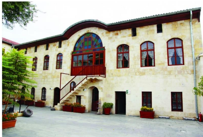
Şekil 5.19 Suyabatmaz Mahallesi Eyvan Örneği
