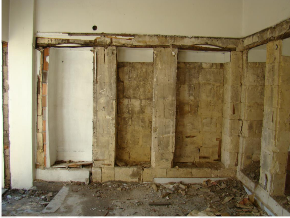
Resim 12- Ahşap Nacar İzleri
