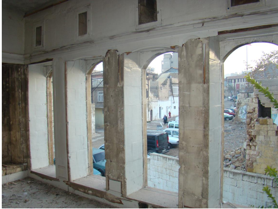
Resim 6- Ahşap Nacar İzleri
