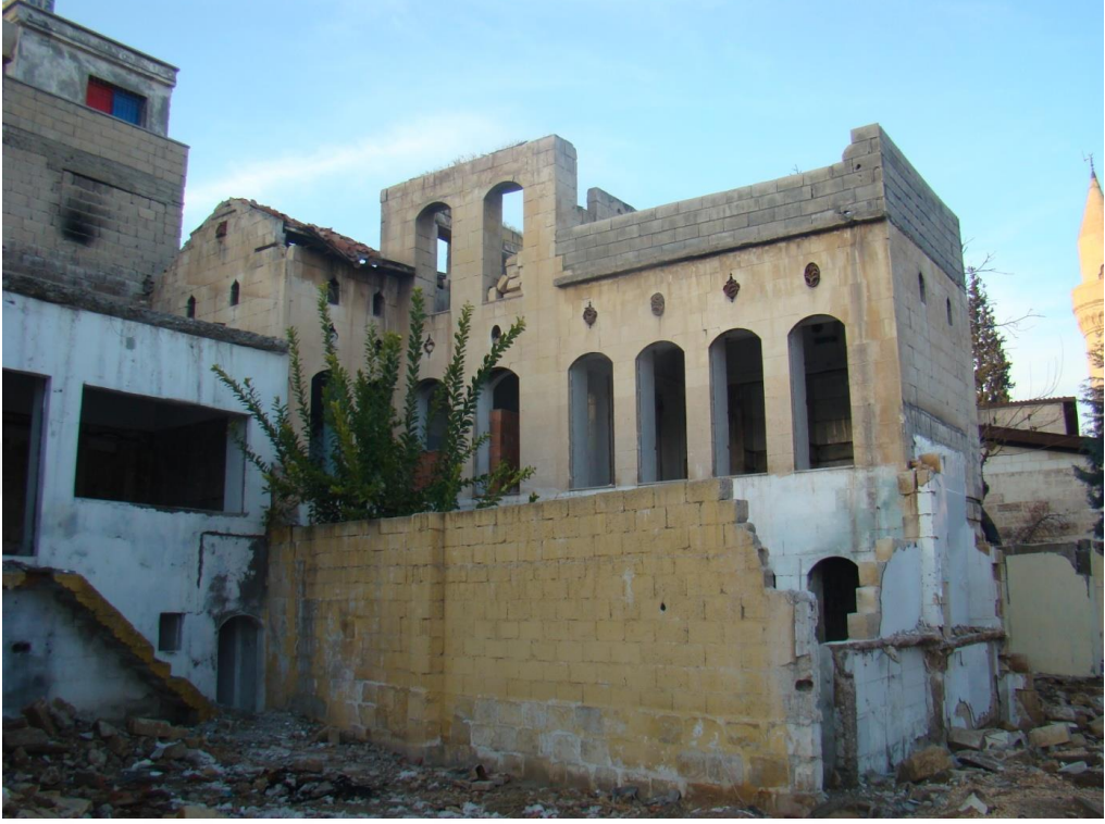
Resim 2- 291 Envanter Nolu Yapı Genel Görünüş
