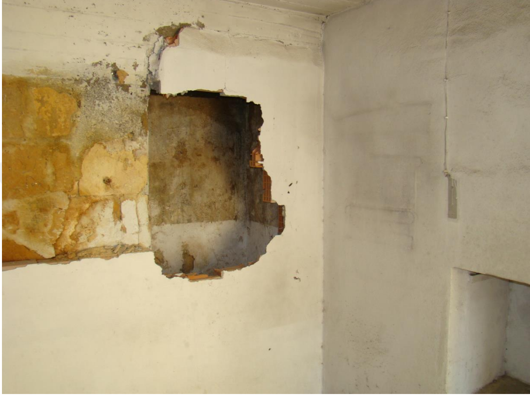
Resim 11- Kesme Taş Önüne Örülen Tuğla Duvar
