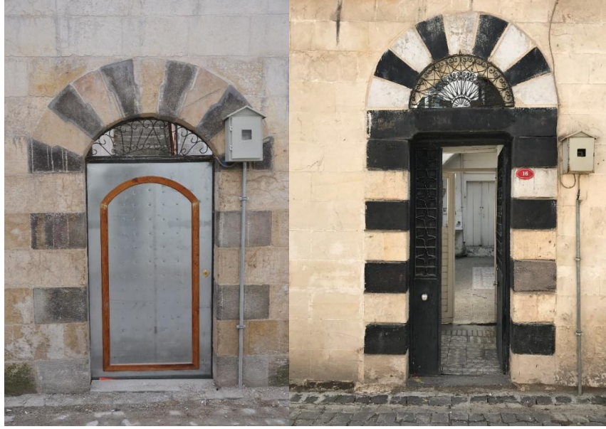
Şekil 5.18 Suyabatmaz Mahallesi Kapı Örneği
