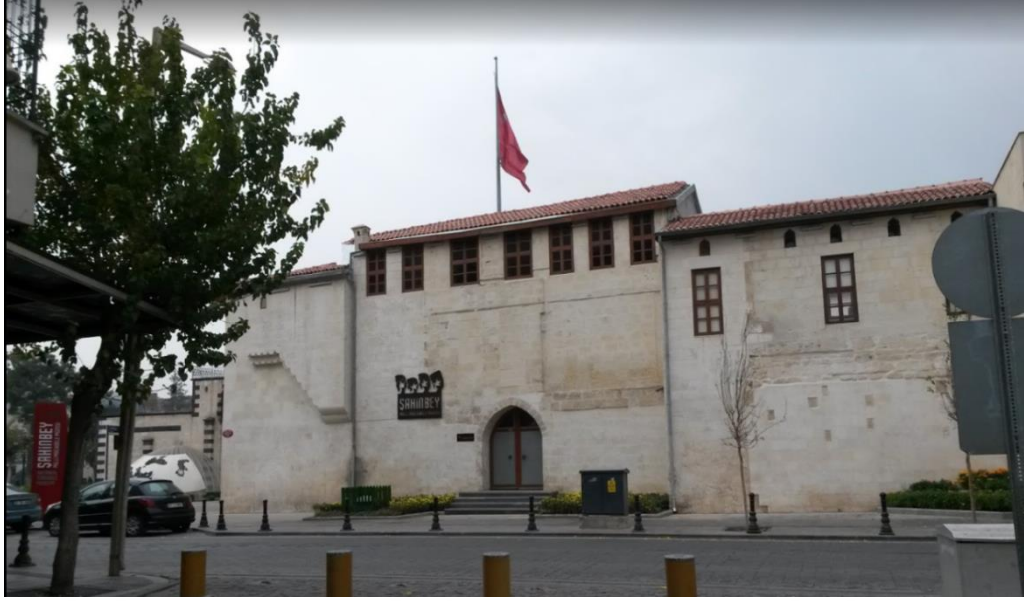
Şekil 5.9 Gaziantep savaş müzesi dış cephesinden bir görünüm (22.04.2018).
