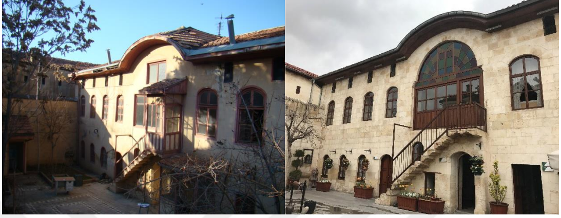
Şekil 5.23 526 ada 13-14 parsel 596 nolu envanter, eski-yeni dış görünüşleri, (Şahinbey Belediye Arşivi, 2018).
