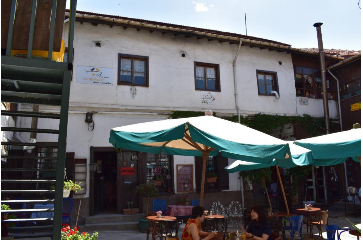
Fotoğraf 178: Pilavoğlu Han Duvar ile Kapatılan Doğu Cephesinden Görünüm
