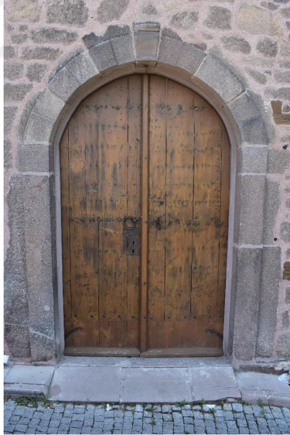
Fotoğraf 152: Çukur Han Batı Cephesindeki Kapıdan Görünüm
