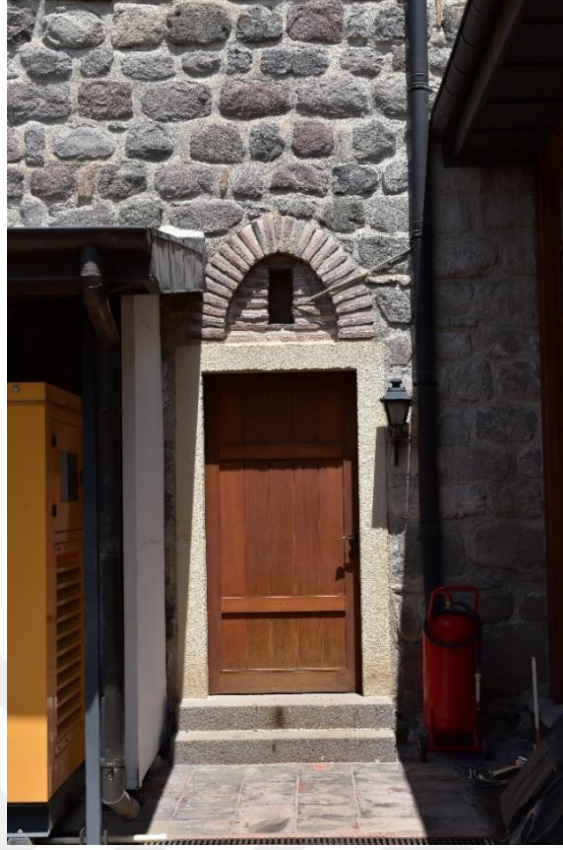
Fotoğraf 81: Çengel Han batı Cephesi Kapıdan Görünüm
