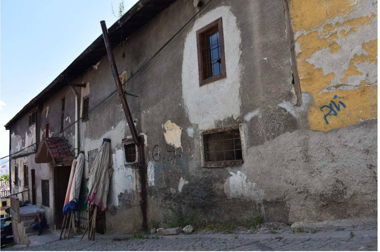
Fotoğraf 191: Pilavoğlu Han Doğu Cephesinden Görünüm
