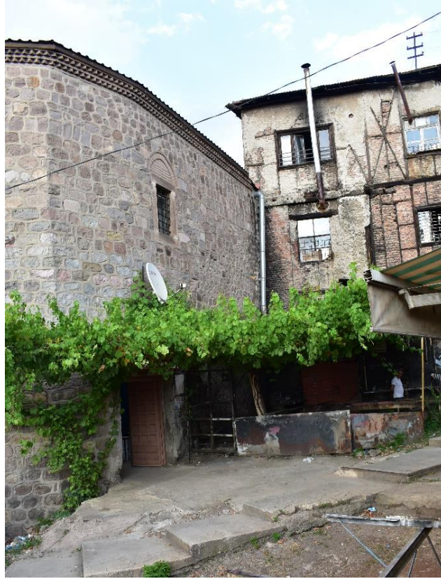
Fotoğraf 146: Suluhan Güney Cephesi Genel Görünüm
