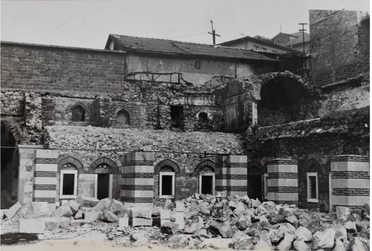
Fotoğraf 114: Suluhan Restorasyon Çalışmaları. (Vakıflar Genel Müdürlüğü Arşivinden.)
