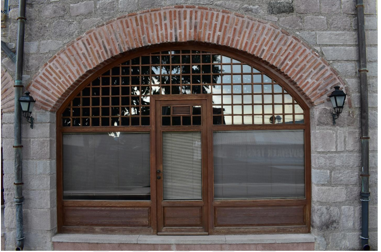
Fotoğraf 101: Safran Han Güneybatı Cephesi Dükkândan Görünüm
