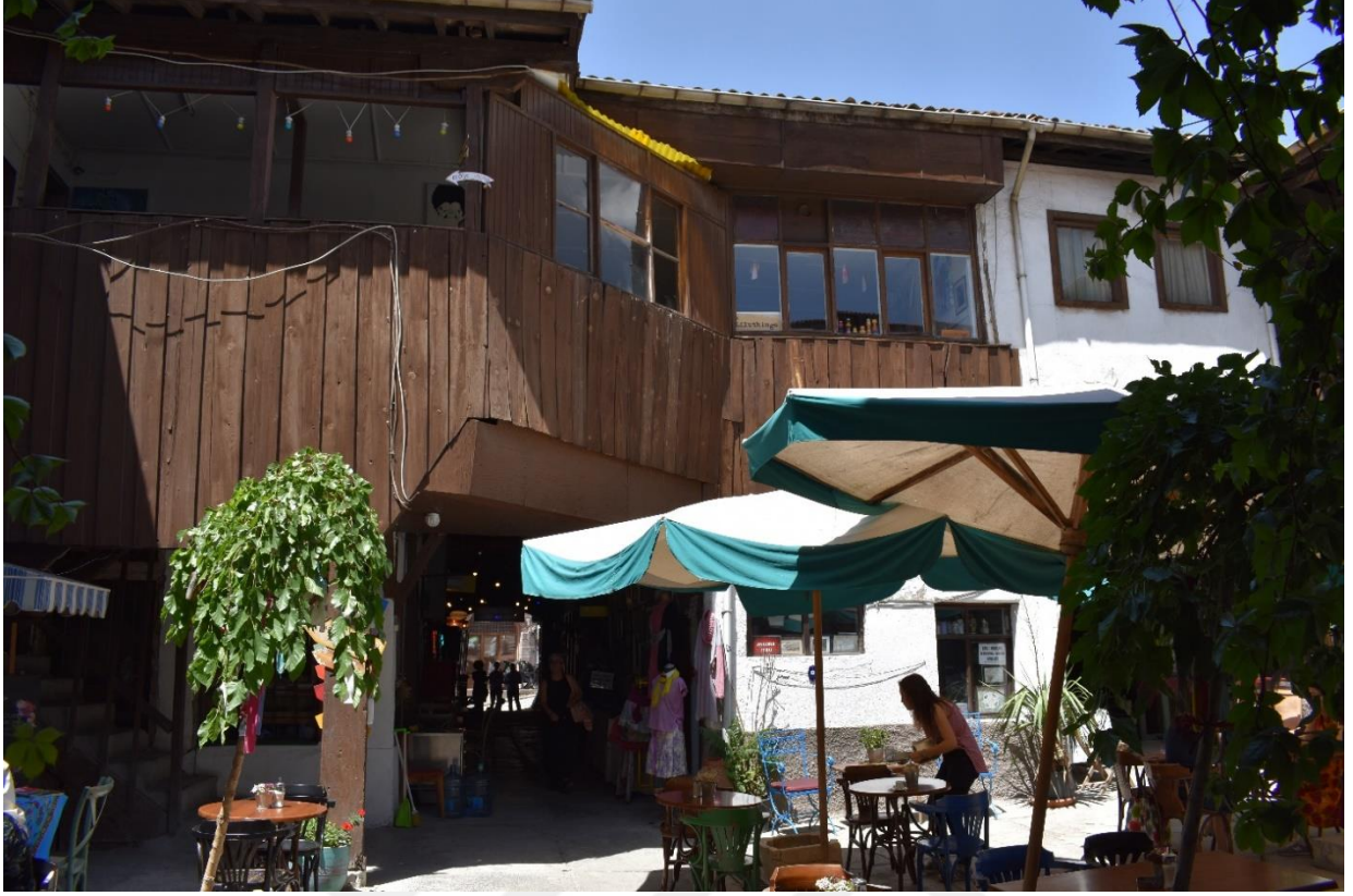
Fotoğraf 183: Pilavoğlu Han Avlunun Batı Cephesi ve Giriş Koridorundan Görünüm
