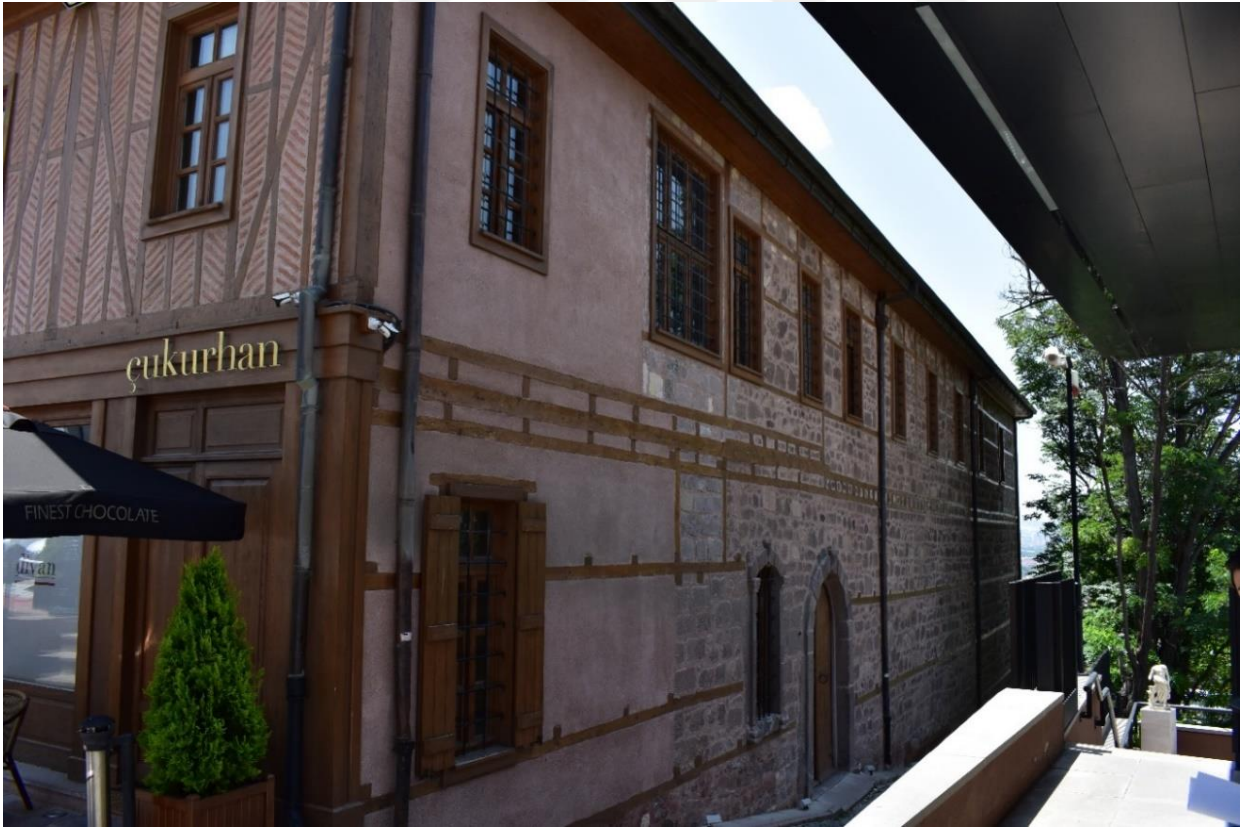
Fotoğraf 168: Çukur Han Batı Cephesi
