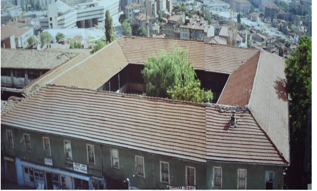
Fotoğraf 161: Çukur Han Restorasyon Öncesi Açık Bırakılan Üst Örtüsü
