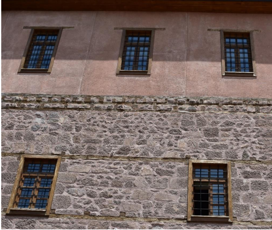
Fotoğraf 154: Çukur Han Güney Cephesi Pencere Detayı
