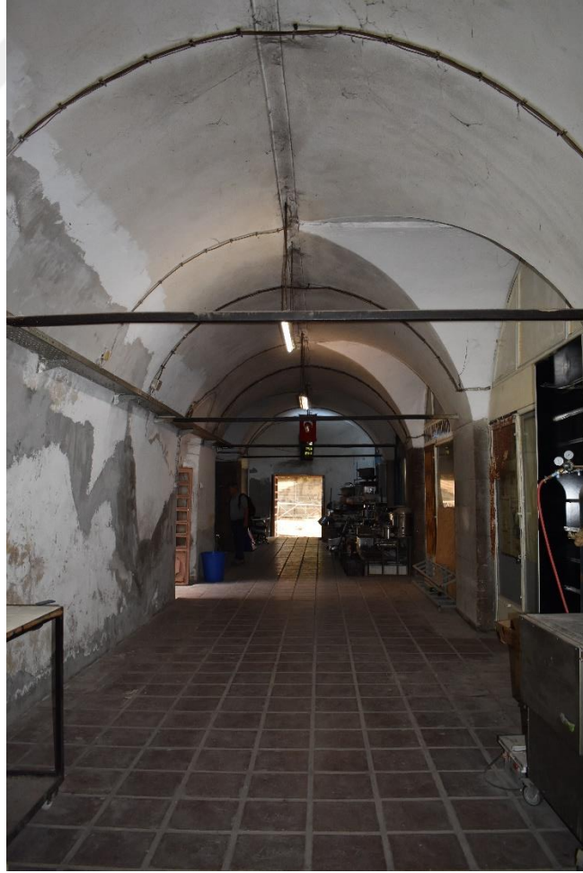
Fotoğraf 140: Suluhan Ahır Bölümü Revaktan Görünüm
