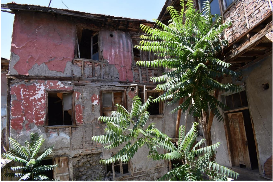
Fotoğraf 217: Yeni Han Ahşap Pencere ve Kat Silmeleri
