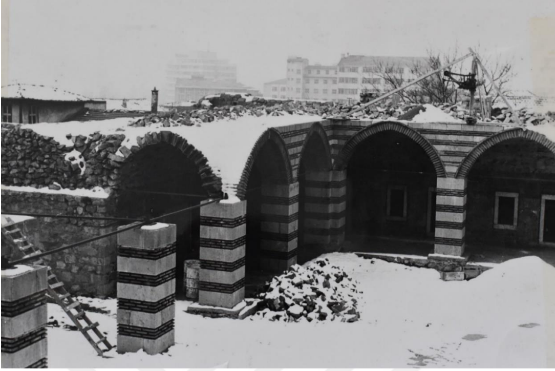
Fotoğraf 115: Suluhan Kemer Ayakları Restorasyon Çalışmaları. (Vakıflar Genel Müdürlüğü Arşivinden.)
