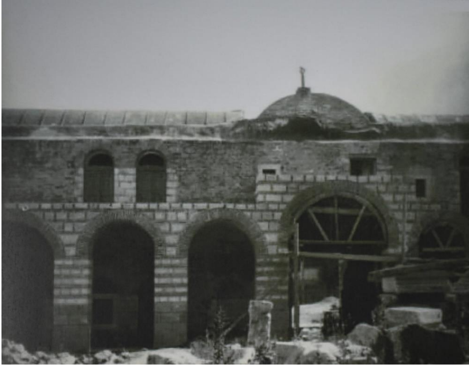
Fotoğraf 50: Kurşunlu Han Restorasyon Çalışmaları. (Vakıflar Genel Müdürlüğü Arşivinden.)
