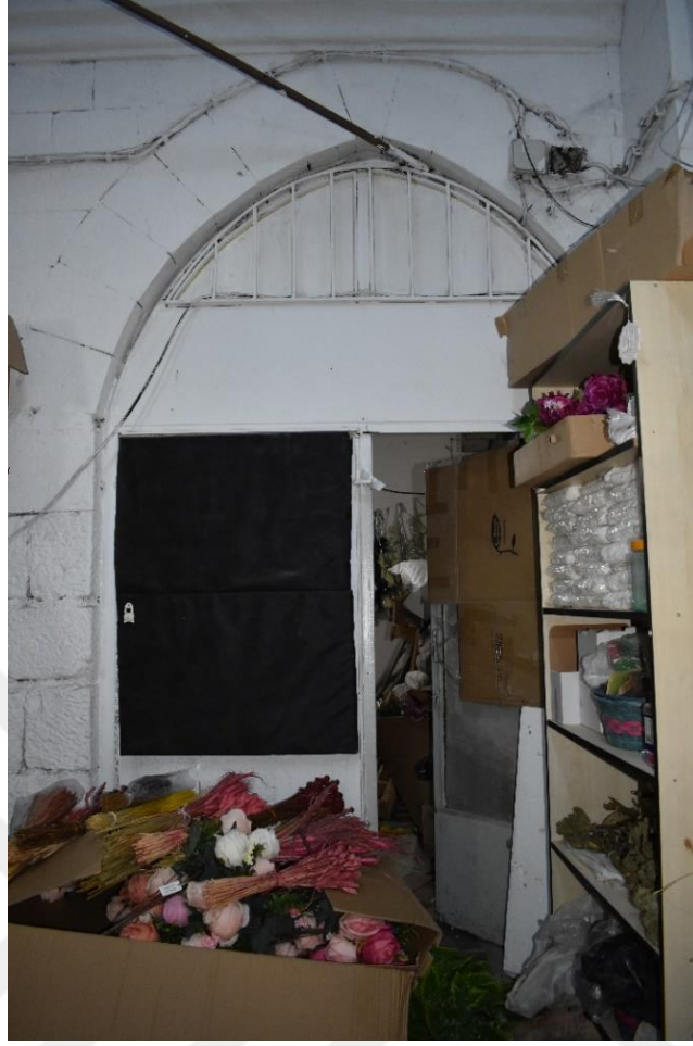
Fotoğraf 125: Suluhan Restorasyon Öncesi Kullanılan Özgün Giriş Kapısı
