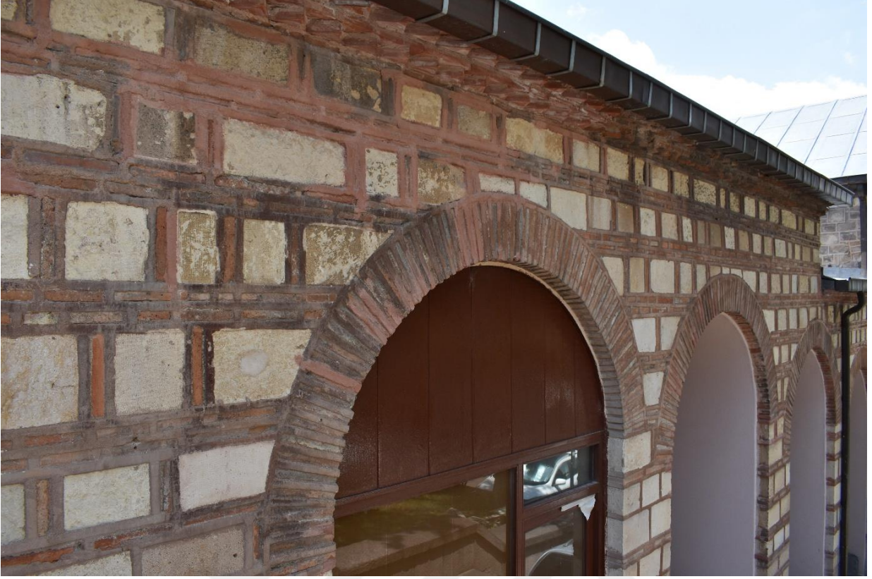
Fotoğraf 29: Kurşunlu Han Cephedeki Saçak Uygulaması Detayı
