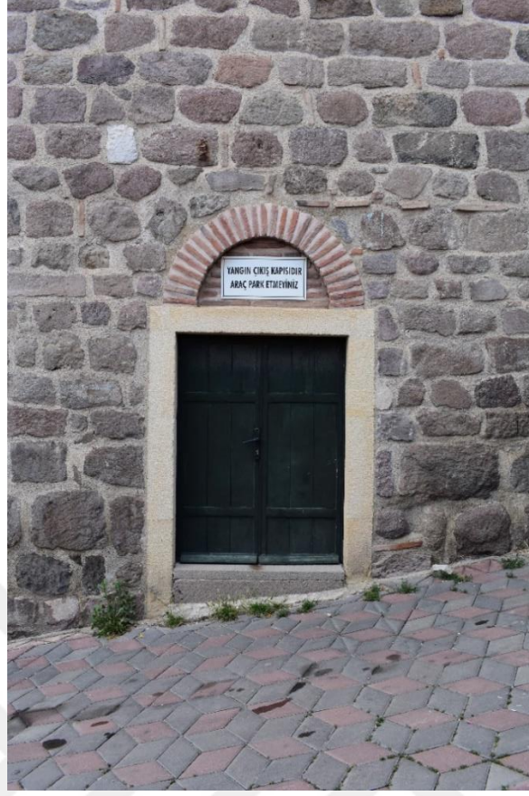
Fotoğraf 79: Çengel Han Güney Cephesi Kapıdan Görünüm
