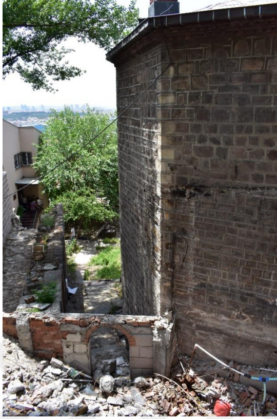
Fotoğraf 47: Kurşunlu Han Doğu ve Güney Cephesi Arasında Pahlanmış Bölüm
