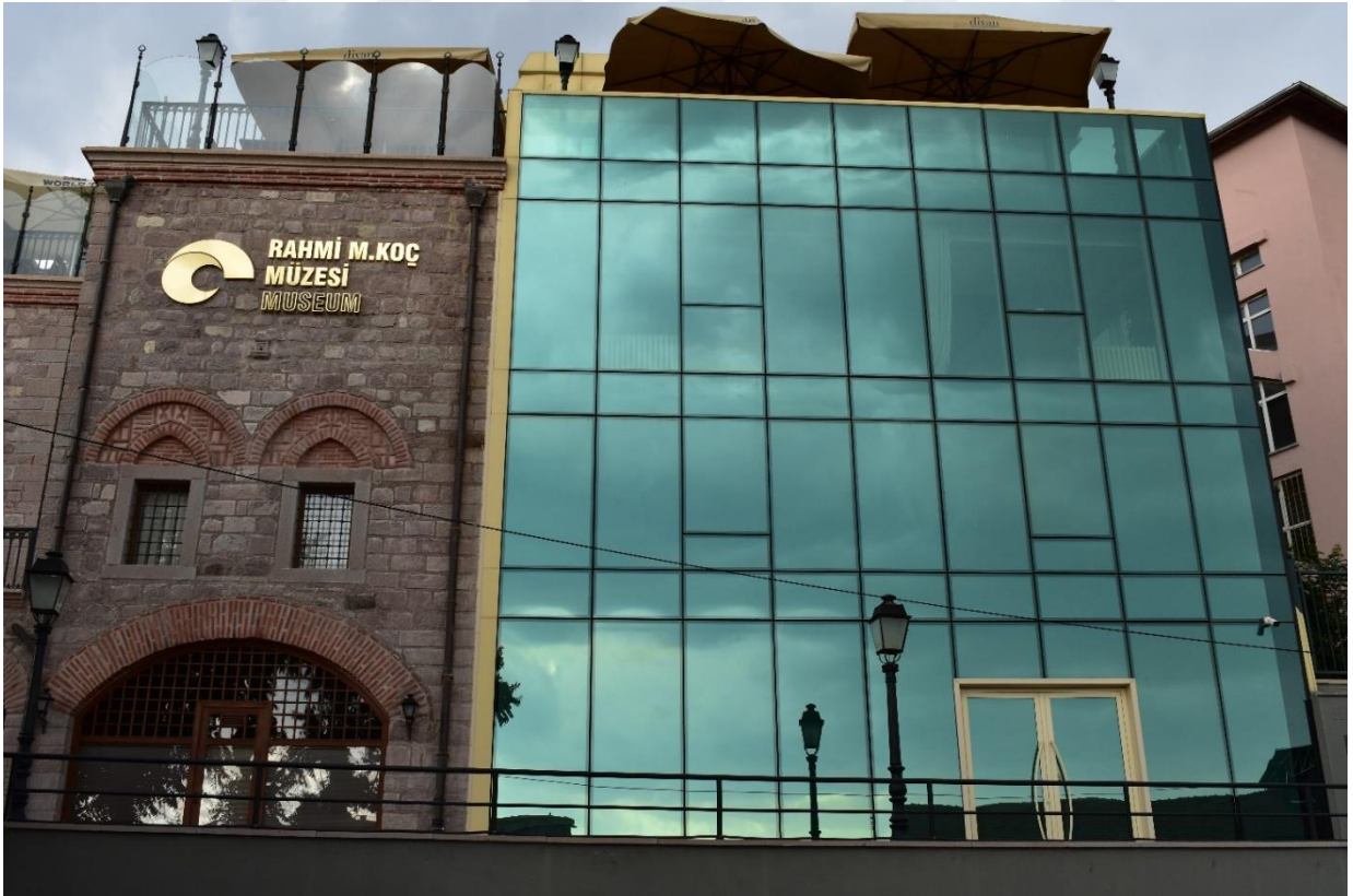
Fotoğraf 102: Safran Han Güneybatı Cephesi Sonradan Eklenen Bölümden Görünüm
