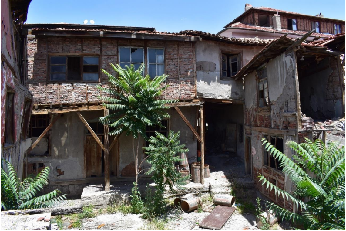
Fotoğraf 220: Yeni Han Ahşap Direkle Taşınan Avlunun Kuzey Cephesi
