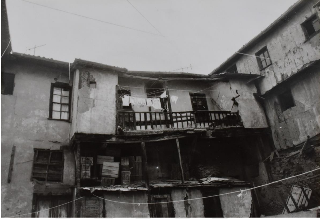
Fotoğraf 197: Restorasyon Öncesi Piriñ Han Avludan Görünüm. (Ankara 2 Nolu Kültür Varlıklarını Koruma Bölge Kurulu Arşivinden.)
