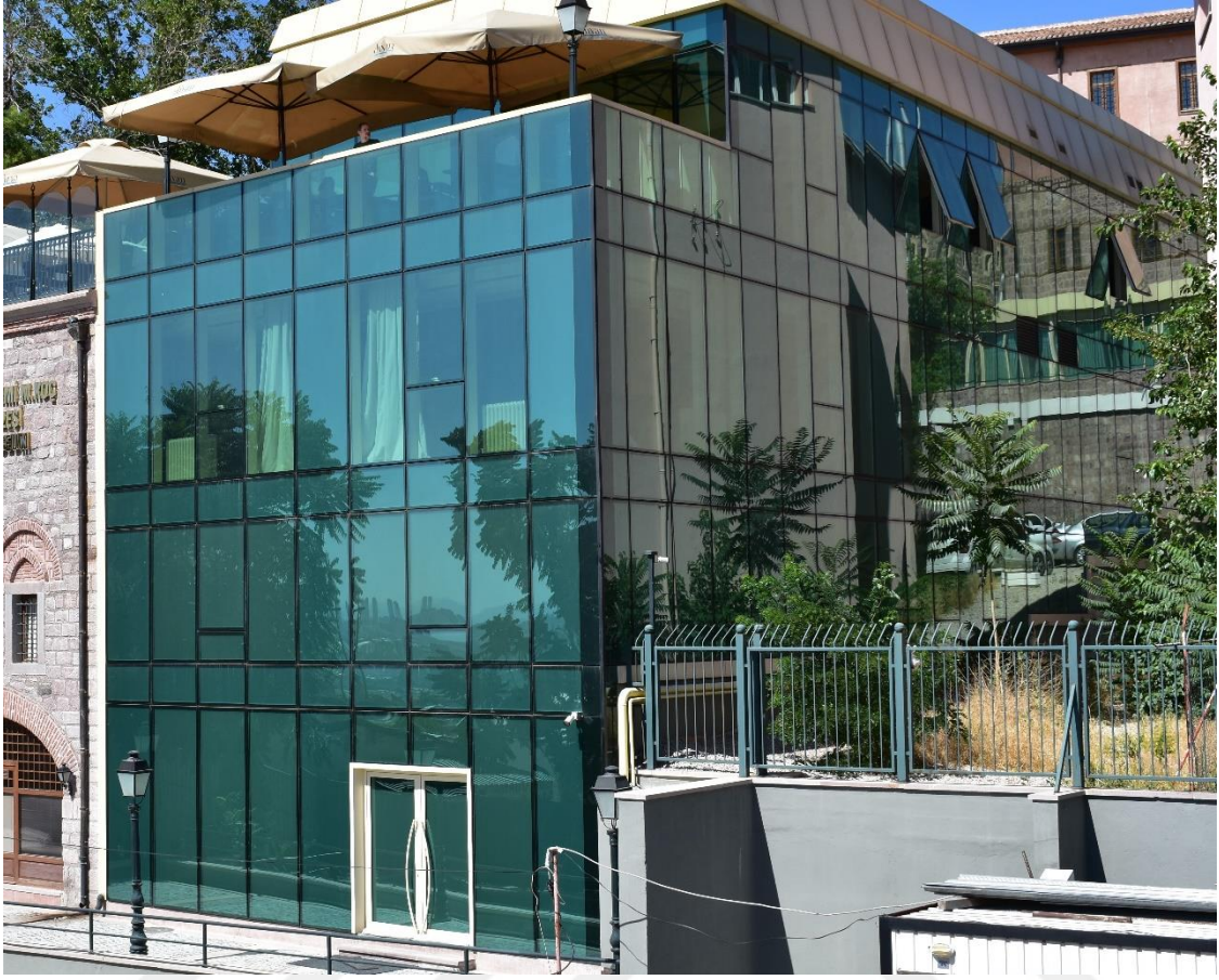
Fotoğraf 107: Safran Han Güney Cephesi Genel Görünüm
