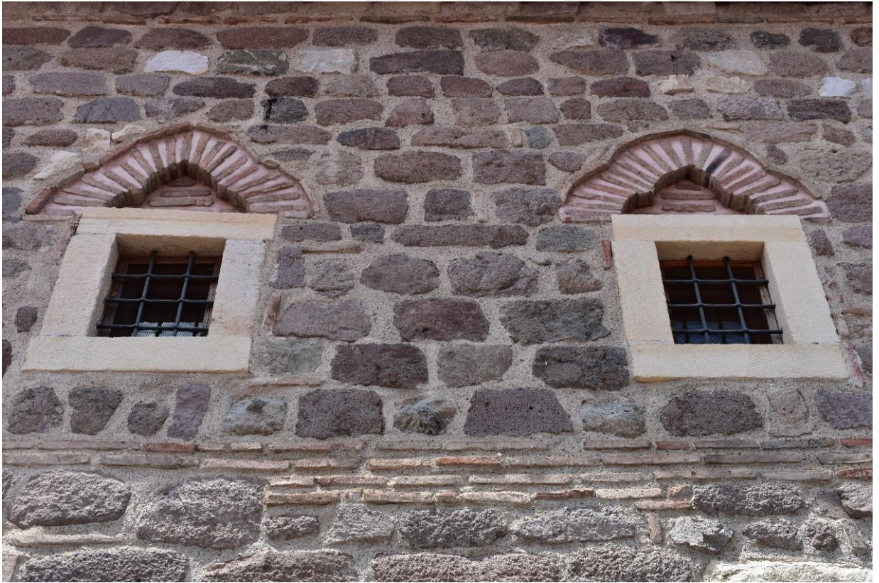
Fotoğraf 78: Çengel Han Güney Cephesi Pencerelelerinden Detay
