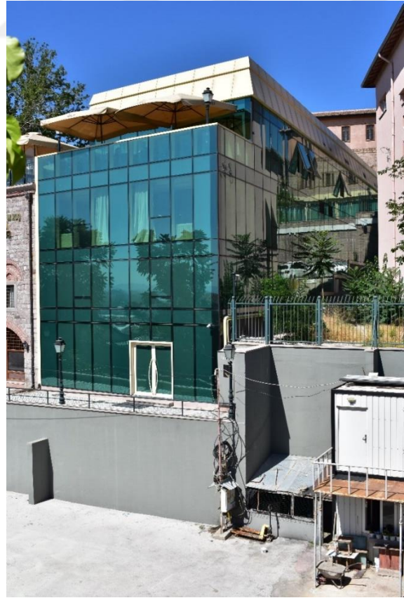
Fotoğraf 90: Safran Han Restorasyon Sonrası Güneydoğu Cephesi
