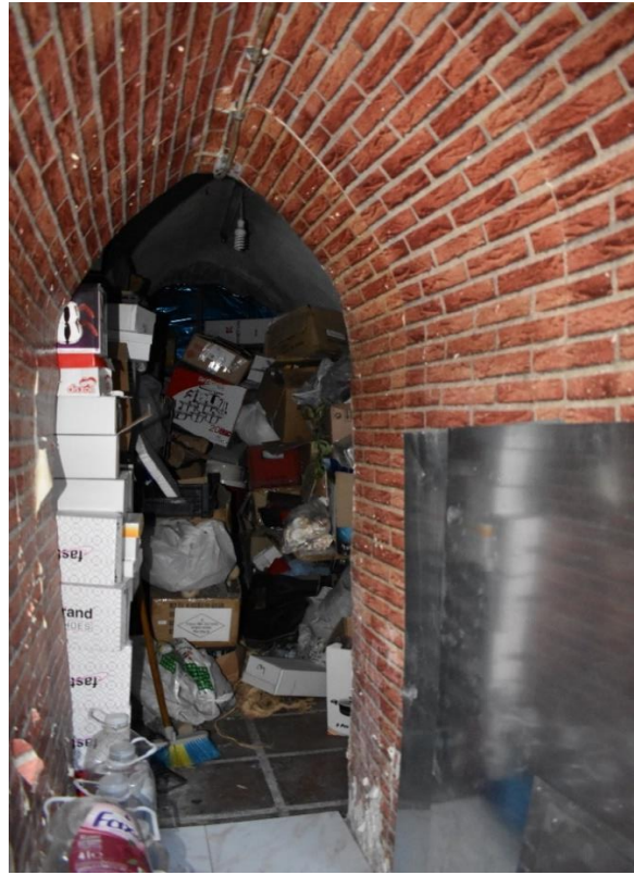
Fotoğraf 128: Suluhan Kapalı Mekanların İçindeki Küçük Odalardan Görünüm
