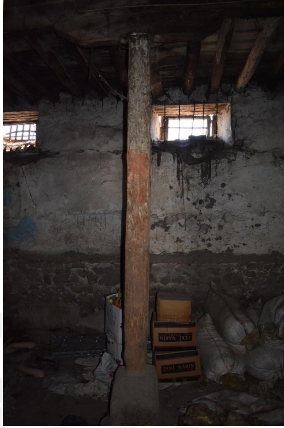
Fotoğraf 235: Kıbrıs Han Ahır Bölümündeki Taşıyıcı Ayak ve Pencereden Detay
