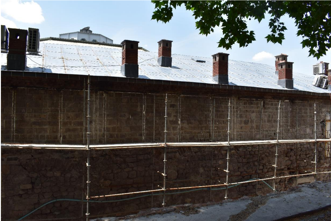
Fotoğraf 46: Kurşunlu Han Doğu Cephesi Genel Görünüm
