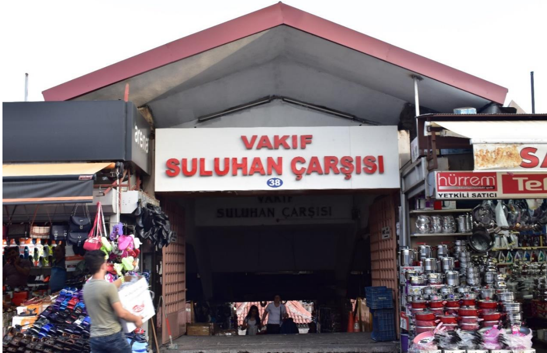
Fotoğraf 124: Suluhan Kuzey Cephesi Ana Giriş Kapısı
