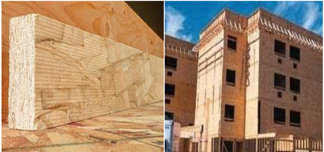
Şekil 1.7 OSL ile yapılmış yapılar (Anonim, 2008d).
