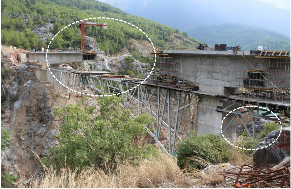
Foto 250. Işıктаşı Sırtı İle Karalharmanı Tepe'nin Kristalize Kireçtaşlarından Oluşan Alt Yamaçları Üzerinde Yapılan Akköprü İnşası. Fotoğrafta da görüldüğü üzere akarsuyun iki yamacını birleştirmek amacıyla yapılan yol inşası sırasında yamaçlarda gelişim göstermiş lapyra oluşumları zarar görmüştür.
