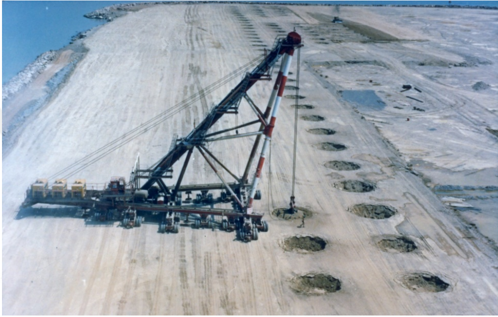
Şekil 2.5. Dinamik kompaksiyon uygulaması ile zemin iyileştirme (Önalp ve Sert, 2010)
