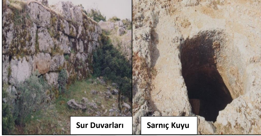
Foto 4: Sur Duvarları ve Sarnıç Kuyu
