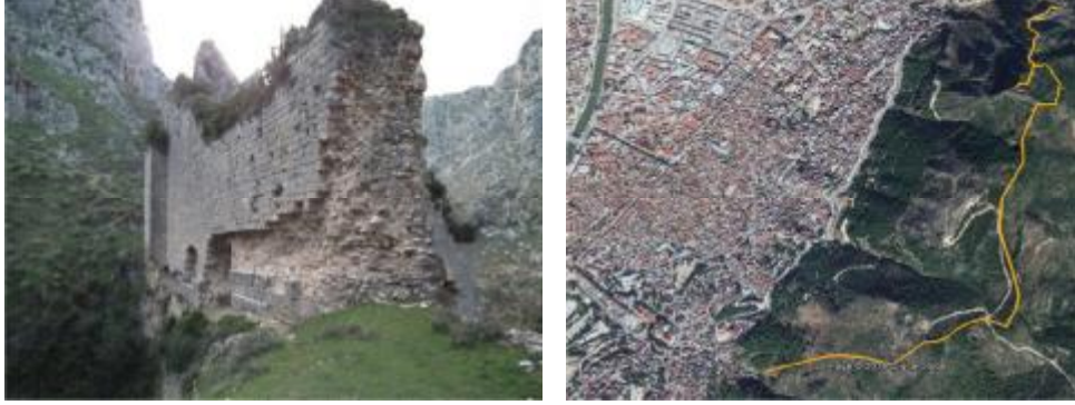
Şekil 4.6. Antakya Kalesinin Mevcut Durumu
