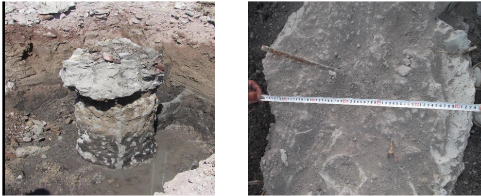
Şekil 4.1. Farklı zemin türlerindeki deneme kazıkları ve çap kontrolü (Çınar, 2014)
