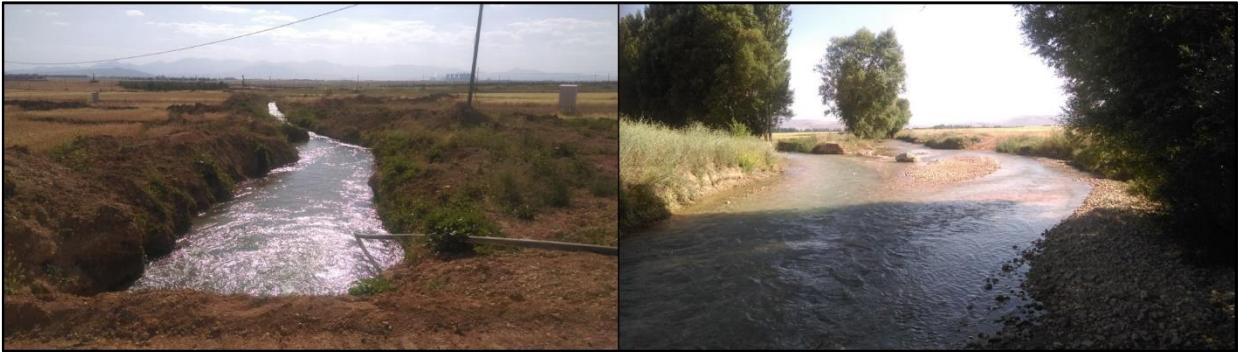
Şekil 3.3. İkiye ayrılan ve beton kaplamasız devam eden kanallar
