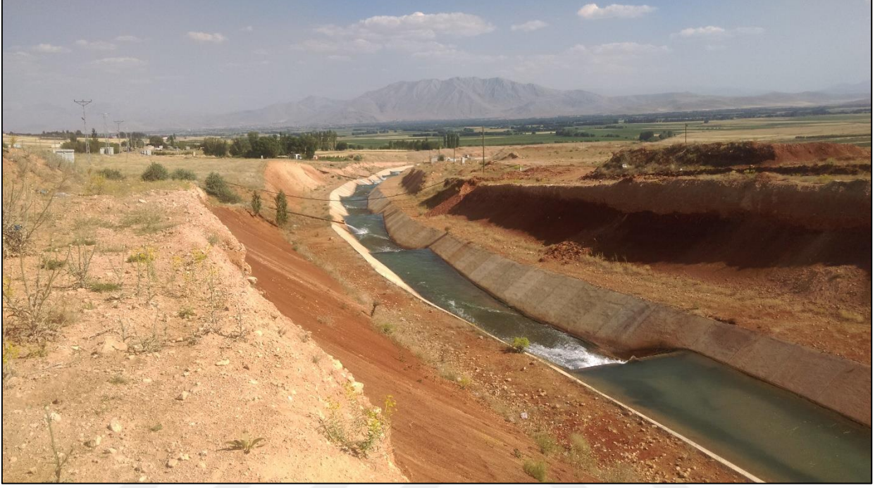
Şekil 3.2. Kışlaköy sektöründe bulunan drenaj kanalı
