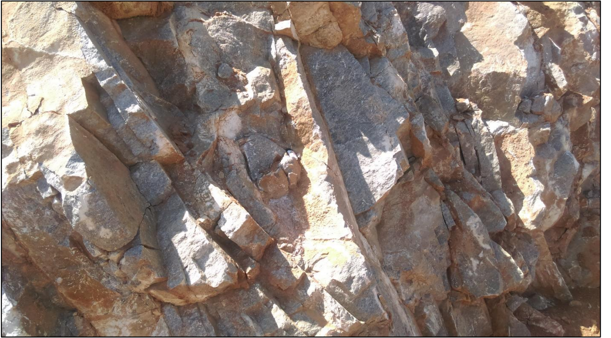
Şekil 2.2. Karagöz köyü yolu üzerinde bulunan yol yarmasında gözlenen Çayderesi formasyonunun yakın çekim görüntüsü
