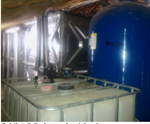
Şekil 4-5 Suda yapılan işlemler (a: klorlama, b: filtreleme)
