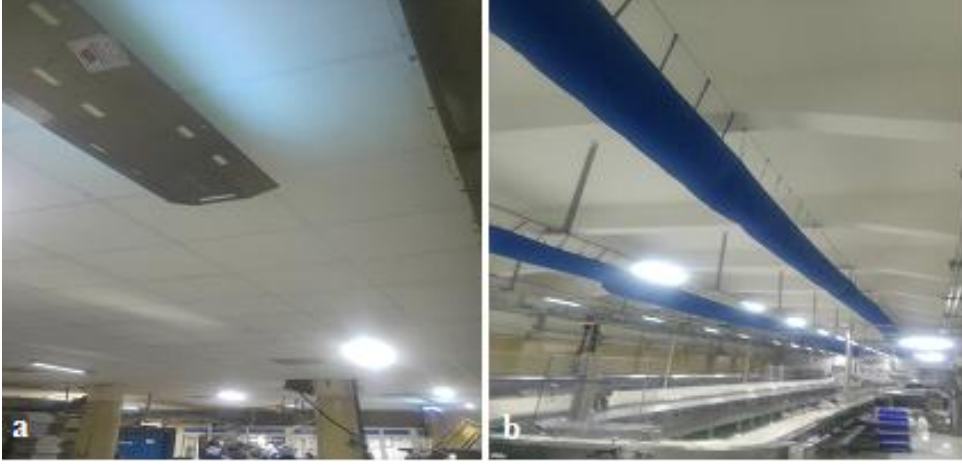
Şekil 4-15 Asma tavanlar (a: sökülmeden önce b: söküldükten sonra)
