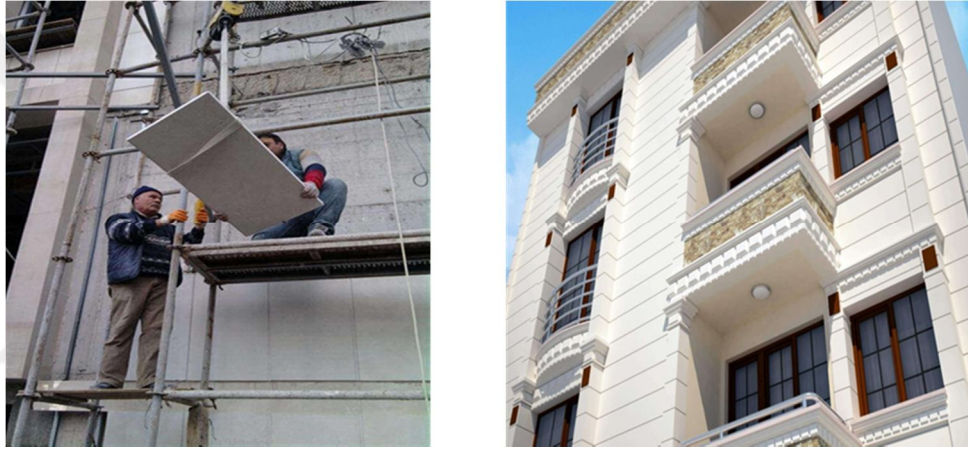
Şekil 3.5. Limra kayacı ile dış cephe kaplama
