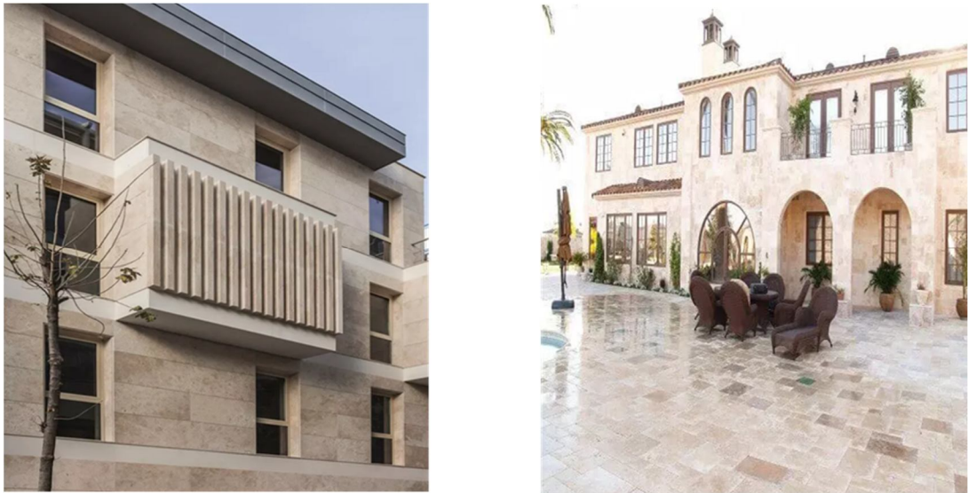
Şekil 3.8. Traverten kayacı ile zemin ve cephe kaplama
