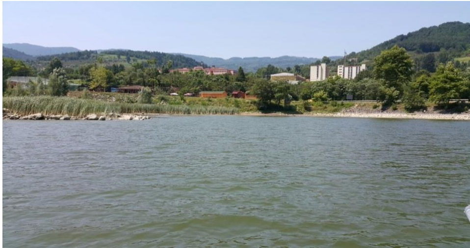
Şekil 3.4. Atıksu Arıtma Tesisi Önü numune alma istasyonu (2)
