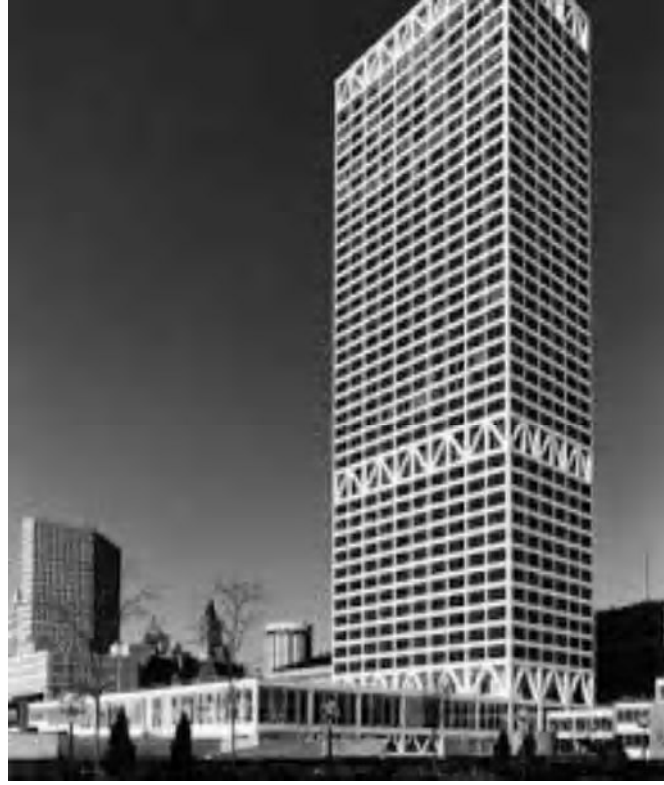
Şekil 3.13. First Wisconsin Bankası, Milwaukee, 1973 (URL-11).
