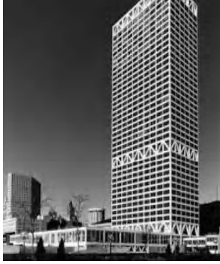
Şekil 4.9. First Wisconsin Bankası, Milwaukee, 1973 (URL-35).
