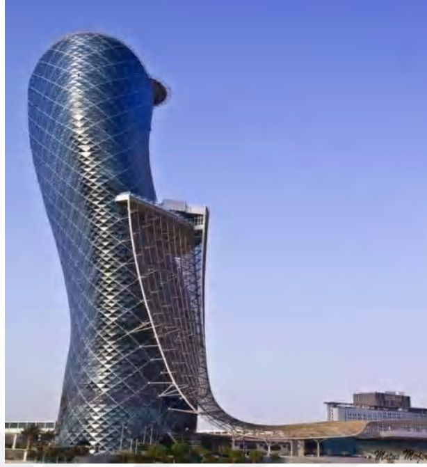
Şekil 4.20. Capital Gate Binası, Abu Dabi, 2011 (URL-46).
