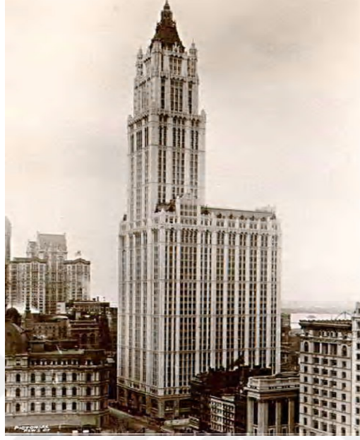
Şekil 2.35. Woolworth Binası, New York, 1913(URL-27).
