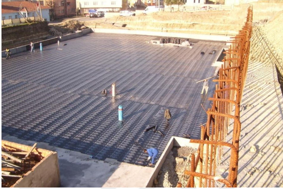
Resim 2.1 : Bitümlü Membran İmalatı (Yavuz Kardeş'in Arşivi).
