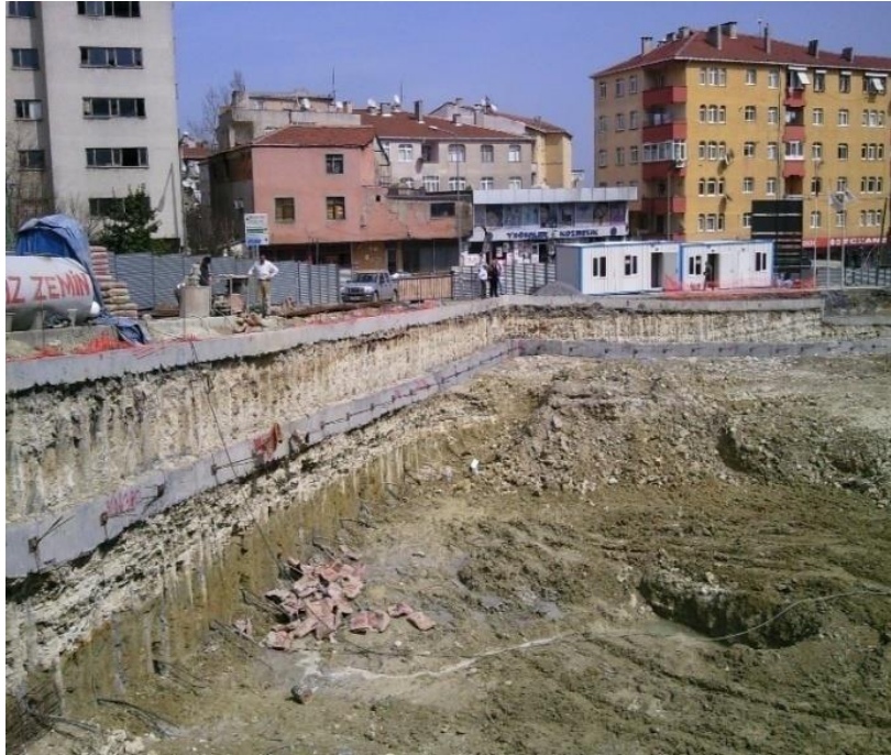
Resim 2.7 : İksa Önlemlili Kazı İmalatı. Yeraltı Suyunun Tespit Edilmesi (Yavuz Karaşahin Arşiv).
