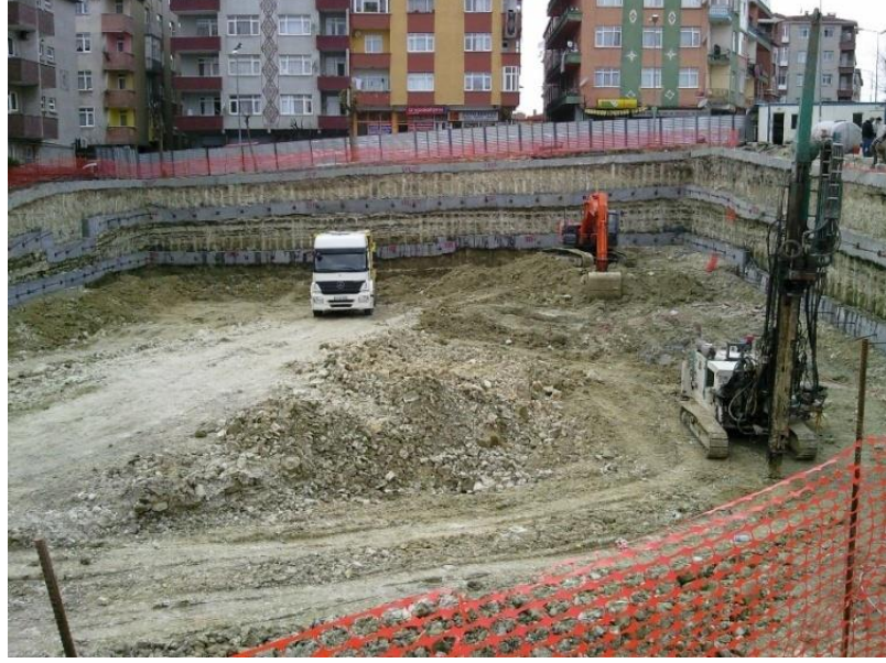
Resim 2.8 : İksalı Kazı İmalatı (Yavuz Karaşahin Arşiv).
