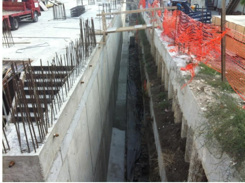
Resim 2.19 : İksa Önlemi Alınarak Yapılan Dik Kazılarda, Çift Yüz Kalıp Kullanma Alanı Yeterli Olduğu Örnek(Yavuz Karaşahin Arşiv).
