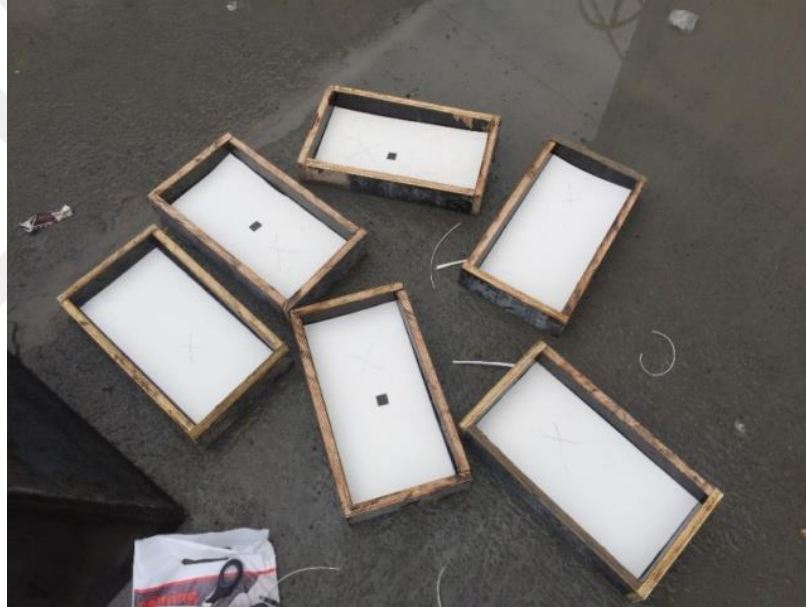
Resim 4.15 : Beton Öncesi Malzemelerin Kalıplara Serilmesi.
