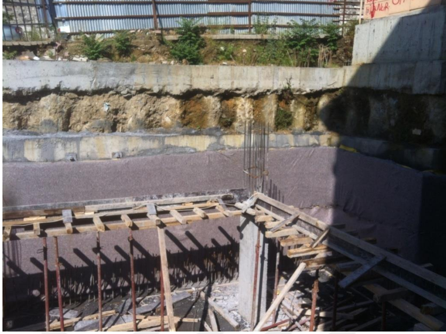
Resim 2.23 : Tek Yüzde PVC Membran Uygulaması Keçe İmalatı (Yavuz Karaşahin Arşiv).
