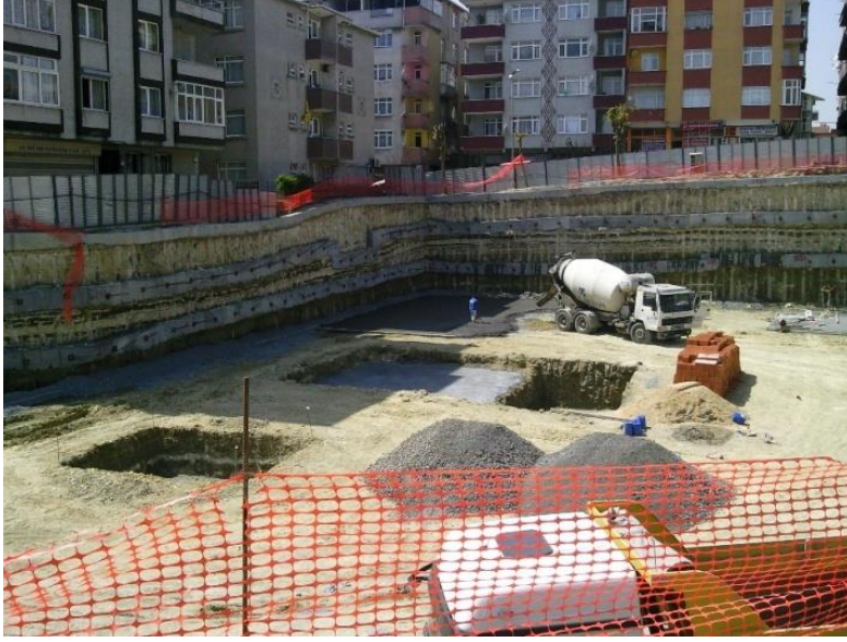
Resim 2.10 : Kazı Kotuna Getirilen Hafriyatın Grobeton İmalatı Önceki Hazırlığı (Yavuz Karaşahin Arşiv).
