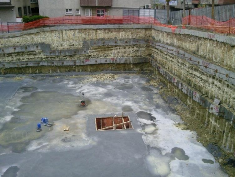
Resim 2.11 : Grobeton Üzerinin Helikopter Makinesiyle Düzeltilmesi (Yavuz Karaşahin Arşiv).
