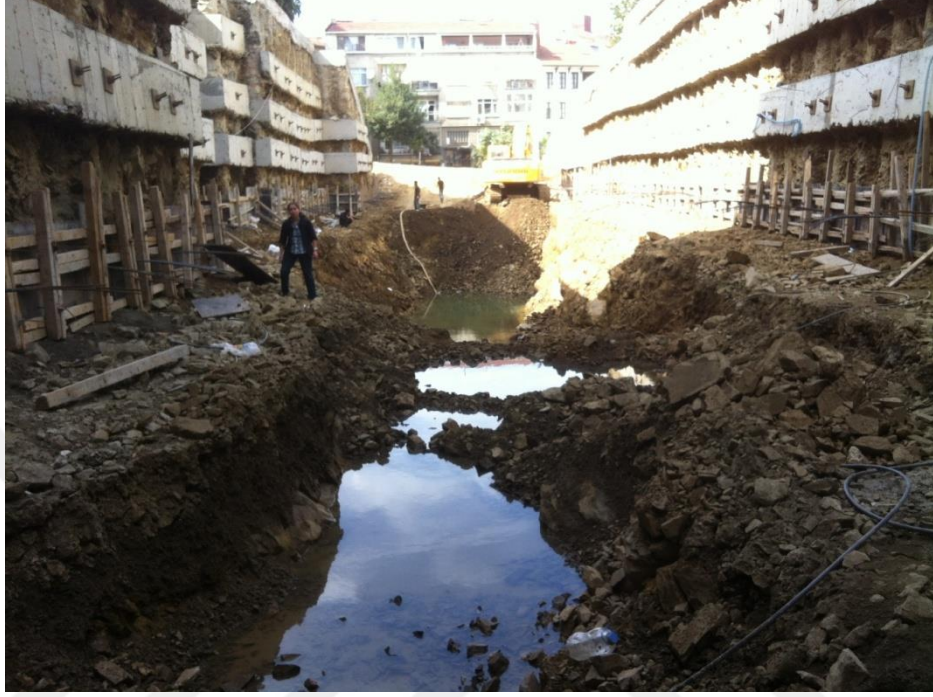
Resim 2.20 : Kazıklı İksa Yapılmış Tek Yüz Perde Uygulaması Yapılacak Olan İnşaat Sahası (Yavuz Karaşahin Arşiv).
