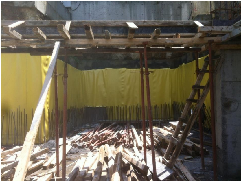
Resim 2.22 : Tek Yüzde PVC Membran Uygulaması (Yavuz Karaşahin Arşiv).
