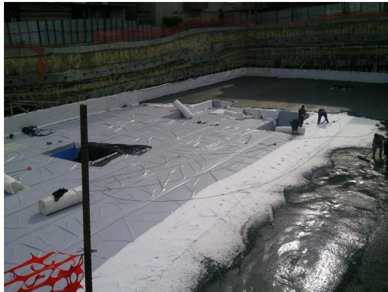
Resim 2.13 : Yalıtım ve Koruma Betonu Uygulaması (Yavuz Karaşahin Arşiv).
