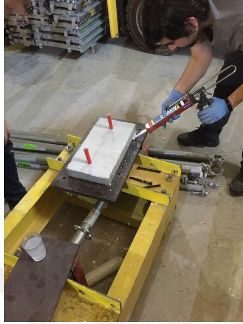
Resim 4.24 : Su Kaçağı Riskine Karşı Mastik Yapılması.
