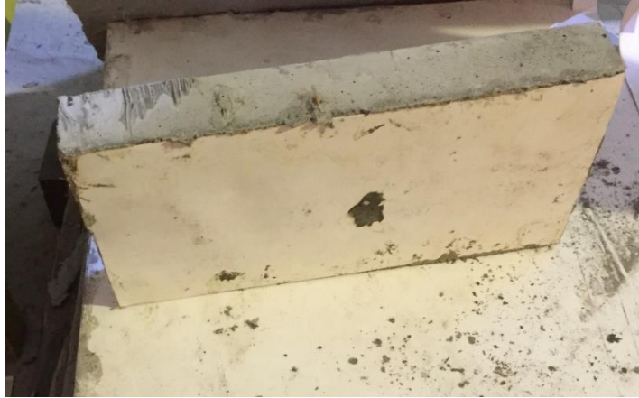
Resim 4.21 : Su Yalıtım Membran Malzemesinin Üzerinde Açılan 25x25 mm Yırtık.
