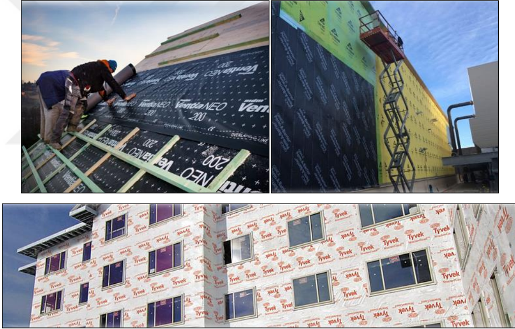
Resim 3.2 : Çatı ve Cephe Yalıtımı (Burak Taylan Arşiv).
