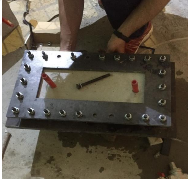
Resim 4.26 : Metal Tablanın Monte Edilmesi
