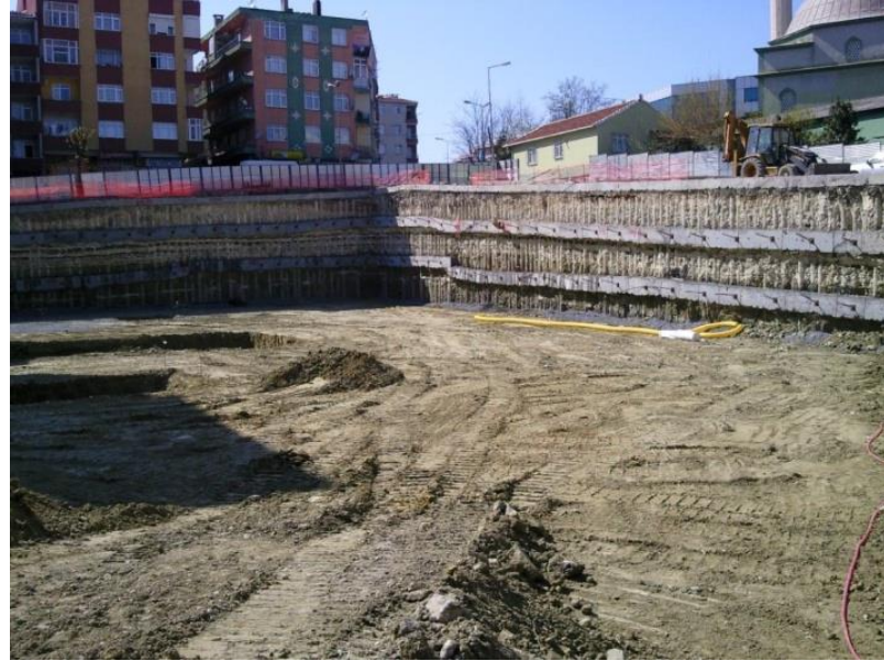
Resim 2.9 : Drenaj Uygulaması Yapılması (Yavuz Karaşahin Arşiv).
