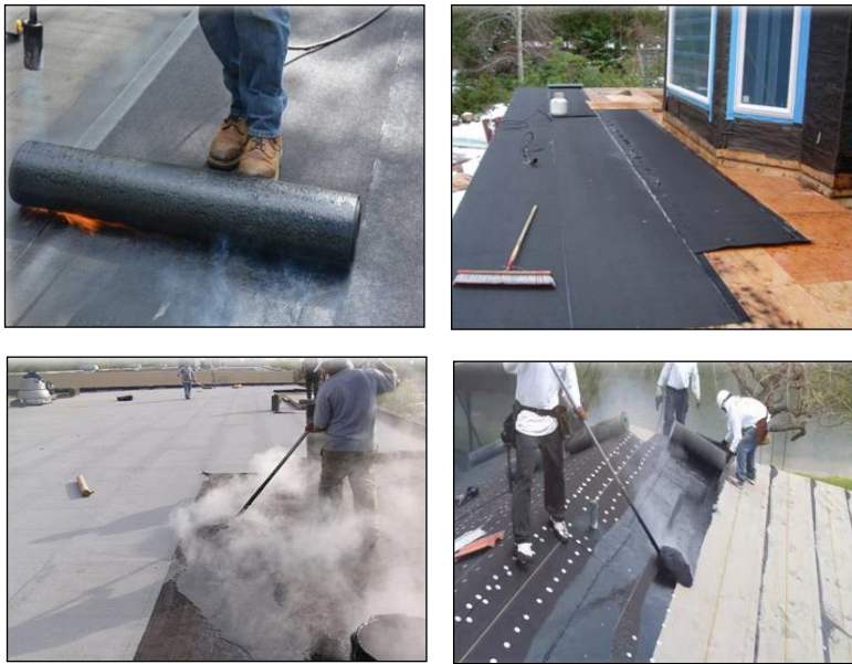
Resim 3.1 : Bitümlü Membran Uygulaması İçin Örnek (Burak Taylan Arşiv)
