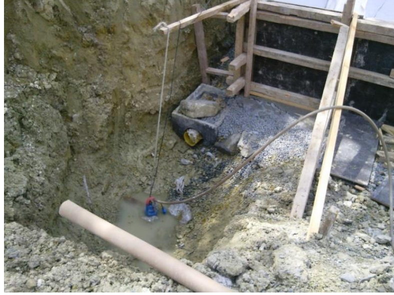
Resim 2.12 : Yer Altı Suyu İnşaat Faaliyetleri Boyunca Toplanması (Yavuz Karaşahin Arşiv).
