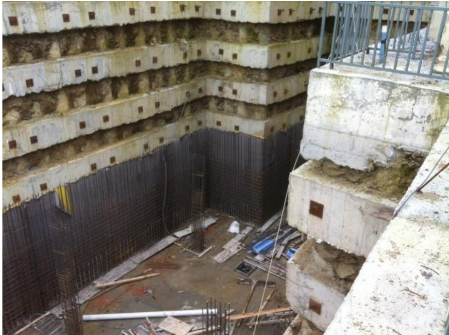
Resim 2.24 : Tek Yüzde PVC Membran Uygulaması Perde Demir İmalatı (Yavuz Karaşahin Arşiv).
