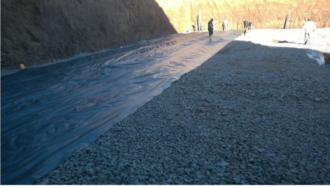
Resim 2.5 : Grobeton Altına Naylon Serilmesi.
