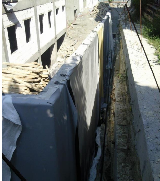
Resim 2.15 : Bina Toprak Altı Perde İmalatları (Yavuz Karaşahin Arşiv).
