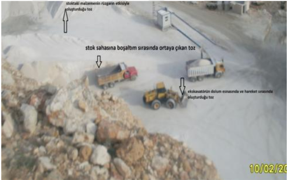
Şekil 1.4. Stok alanında yapılan doldurma, boşaltma işlemlerinin meydana getirdiği toz konsantrasyonu
