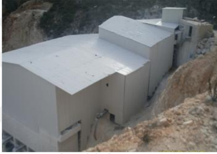
Şekil 4.1. Tesisin uygun malzeme ile kaplanması
