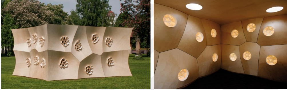
Resim 4.6. Hygro Skin biyomimetik yapı kabuğunun iç ve dış görünümü (URL-53)
