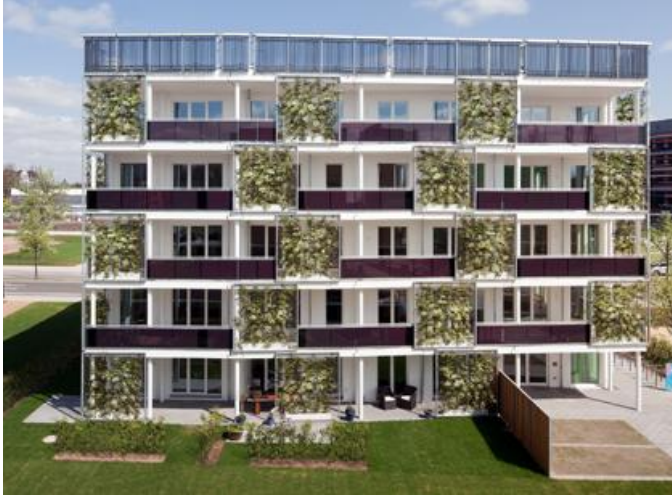
Resim 3.3. Smart is Green binası, faz değişim malzemeli bina kabuğu, (URL-46)
