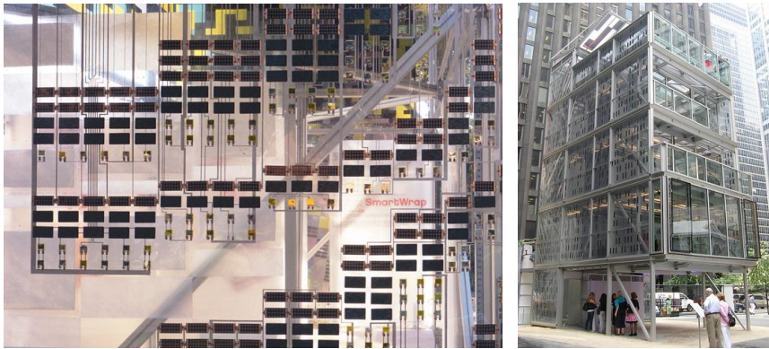
Resim 3.1. SmartWrap™ akıllı kompozit cephe malzemesi (URL-44)
