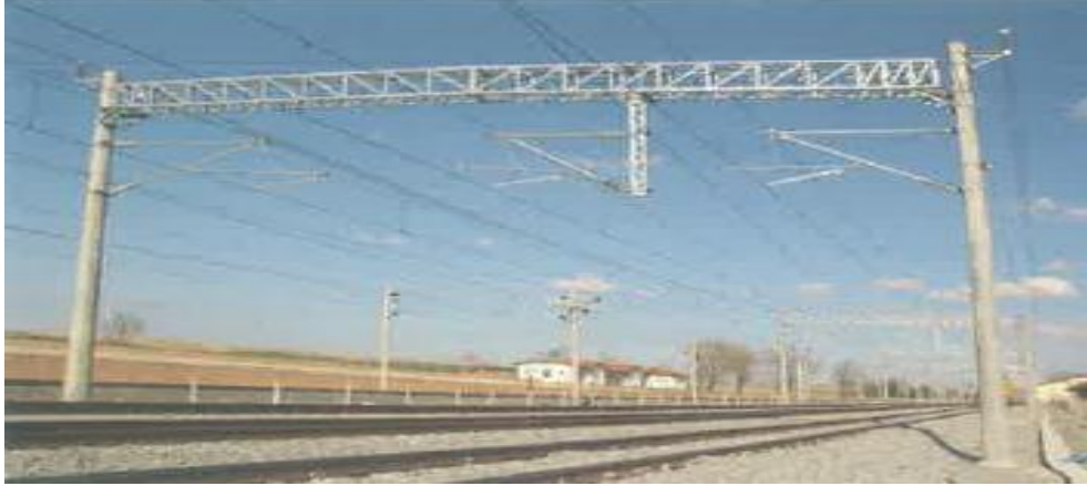
Şekil 3. 37 . Portallı beton direk (Puschmann R.,2010).
