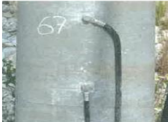
Şekil 3. 34. Direkteki topraklama bağlantısı (Kiessling, 2009)
