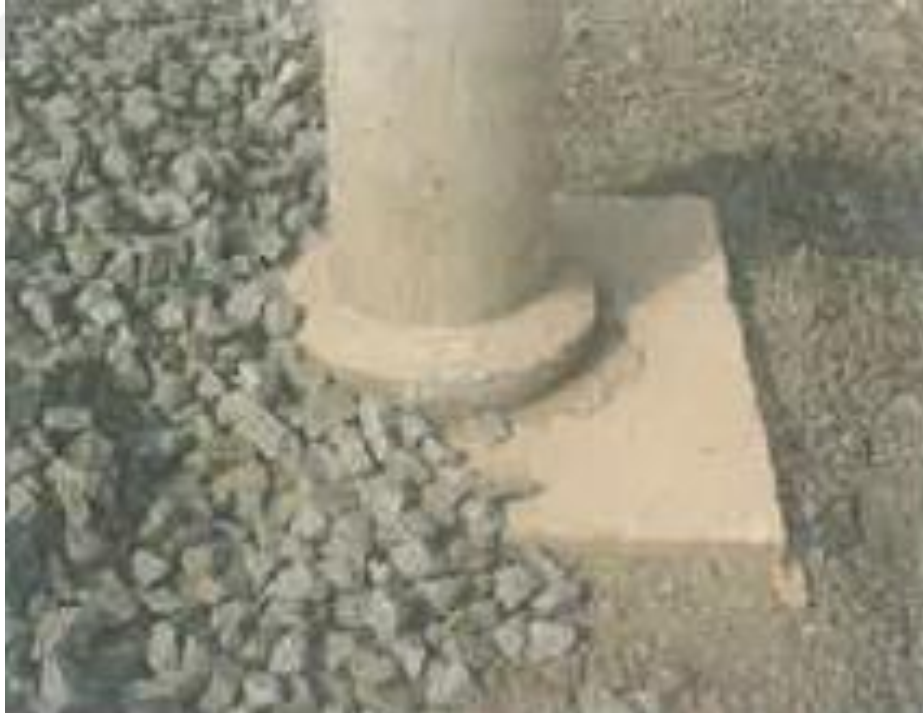
Şekil 3. 35. Beton direk temeli (Kiessling, 2009)
