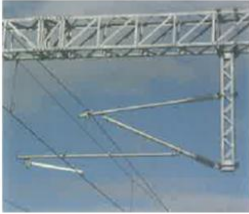
Şekil 3. 30. Portal içindeki konsol (Puschmann R., 2010)
