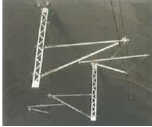
Şekil 3. 31. Tünel içindeki konsol
