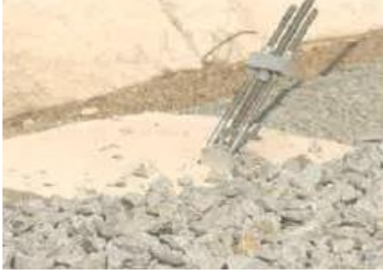
Şekil 3. 36. Çelik direğin temele montajı (Kiessling, 2009)
