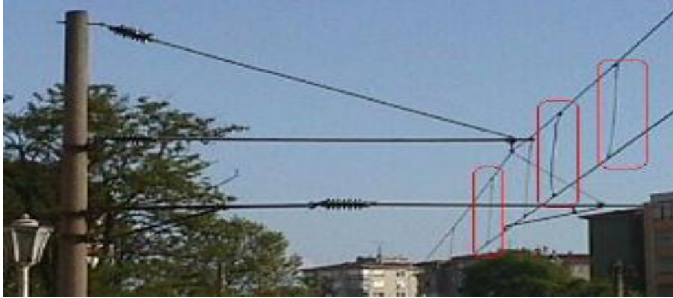
Şekil 3. 25. Pandül montajı (Puschmann R., 2010)
