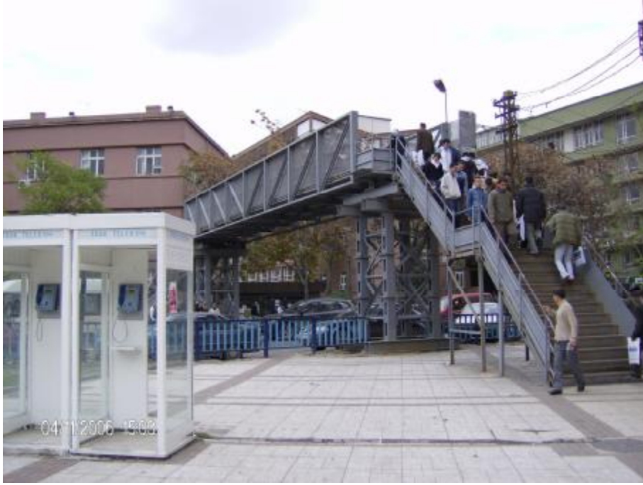
Şekil 4.17. Ankara - Mithatpaşa Caddesi üst geçit uygulaması
