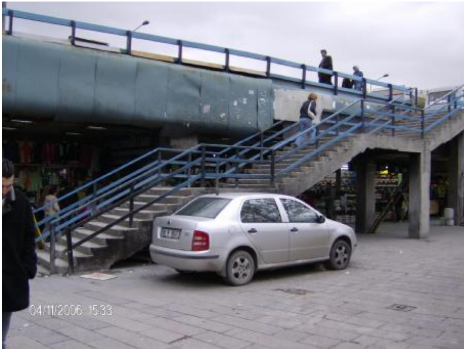
Şekil 4.18. Ankara - Sıhhiye Köprüsü üst geçit uygulaması
