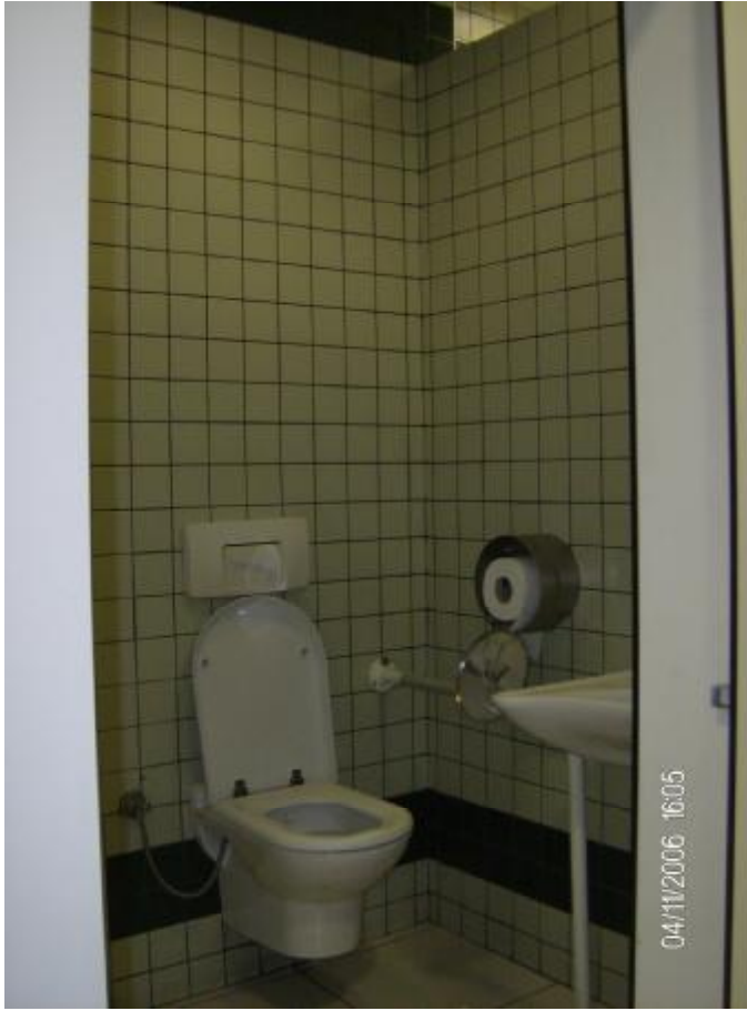
Şekil 4.26. Ankara şehri alış veriş merkezi tuvalet düzenlemesi
