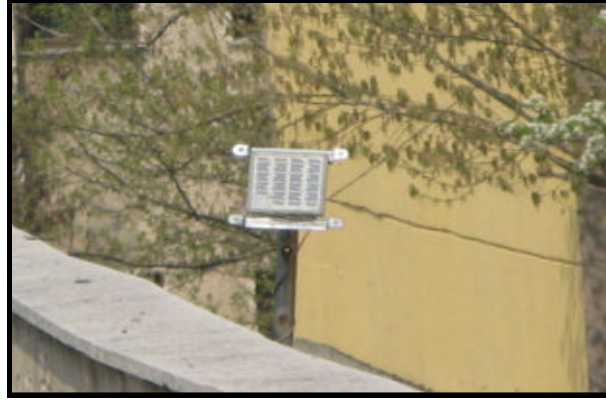
Şekil III.3 Güneş Pili Montaj Noktası
