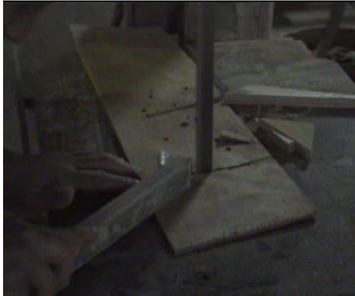
Şekil4.4 Çekirdek malzemesinin uygun boyutlarda kesilmesi
