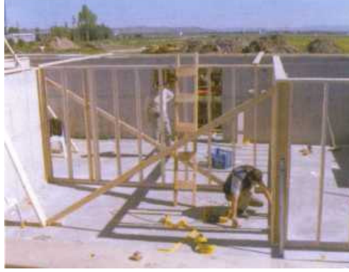
Resim 6.2 Bodrum kat ahşap bölme duvarları
