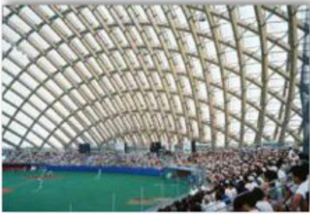
Resim 4.2 Dünyanın en büyük ahşap kubbesi Odate Dome
