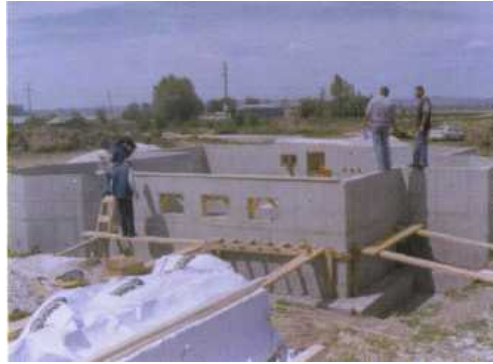
Resim 6.1 Ahşap ev temel ve bodrum kat aşaması
