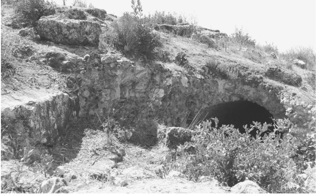
Res. III.19. Alexandria Troas kenti odeion yapısı. Tonozlu alt yapı ve destek duvarının doğudan görünümü (foto. Deniz Öztürk)
