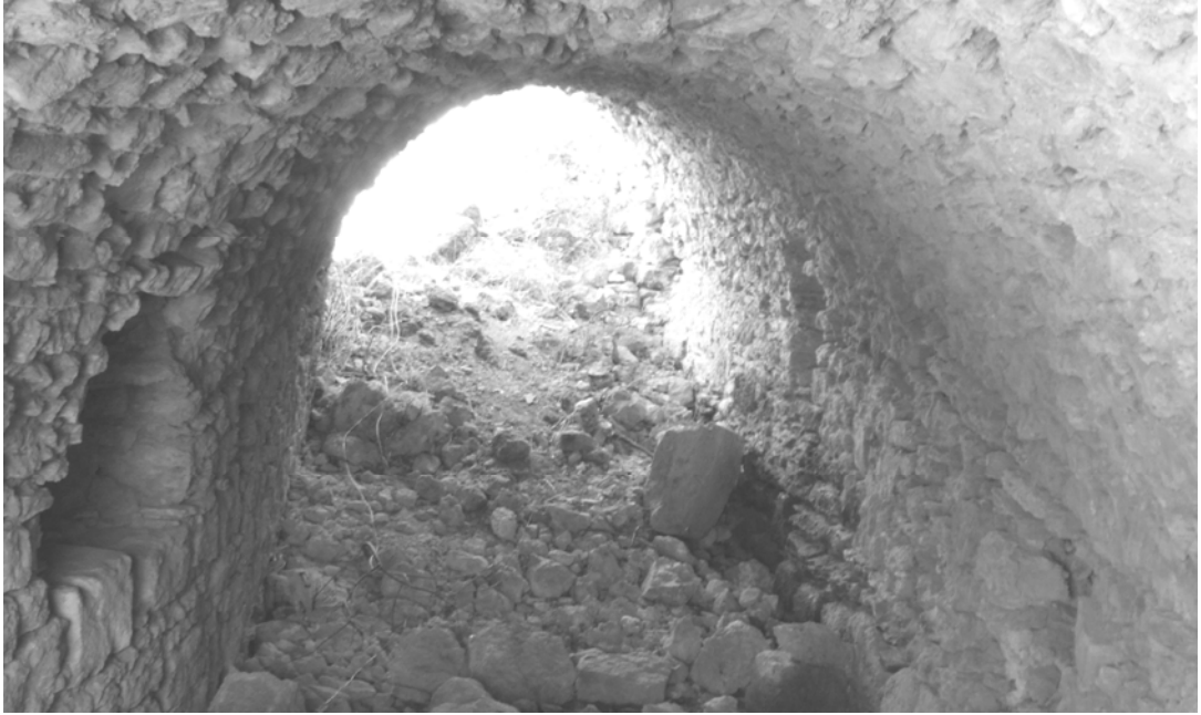
Res. III.24. Alexandria Troas kenti odeion yapısı. Tonozlu alt yapının ve iç kısımda yer alan nişlerin güney yönünden bir görüntüsü (foto. Deniz Öztürk)
