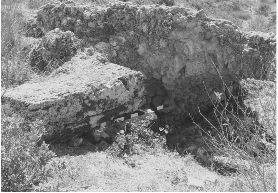
Res. III.21. Alexandria Troas kenti odeion yapısı. Tonozlu alt yapıda yer alan kemerler ve destek temelleri (foto. Deniz Öztürk)
