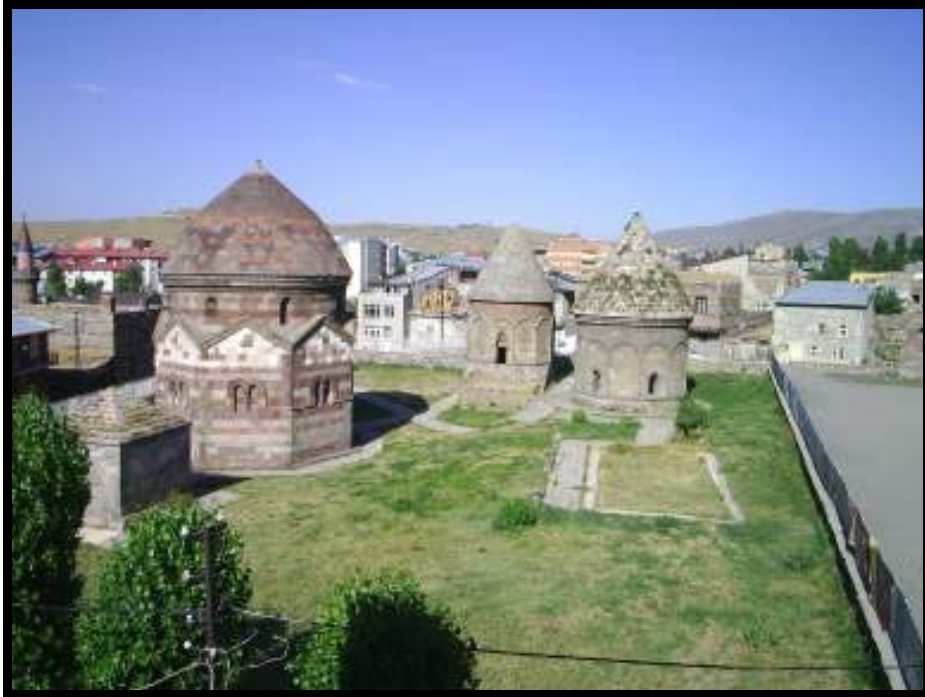
Şekil 3.6. Üç kümbetlerden bir görünüm
