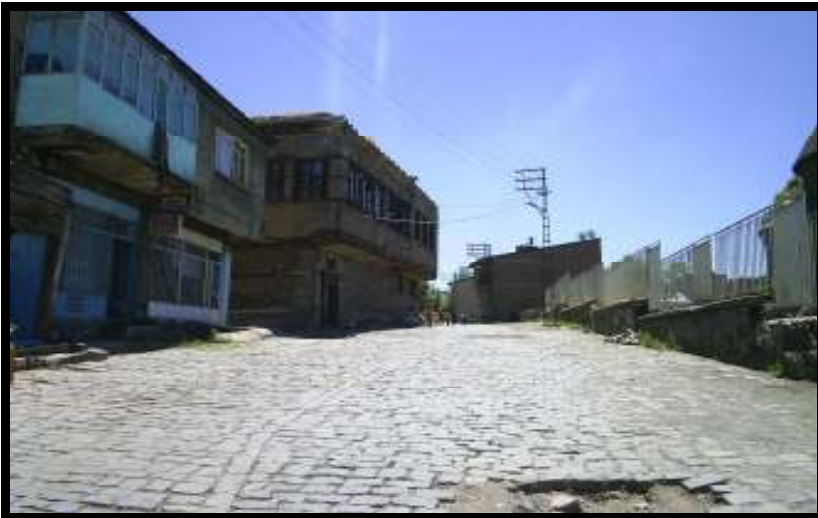
Şekil 4.17. Üç Kümbetler etrafındaki bakımsız yapılar ve bozuk yollar
