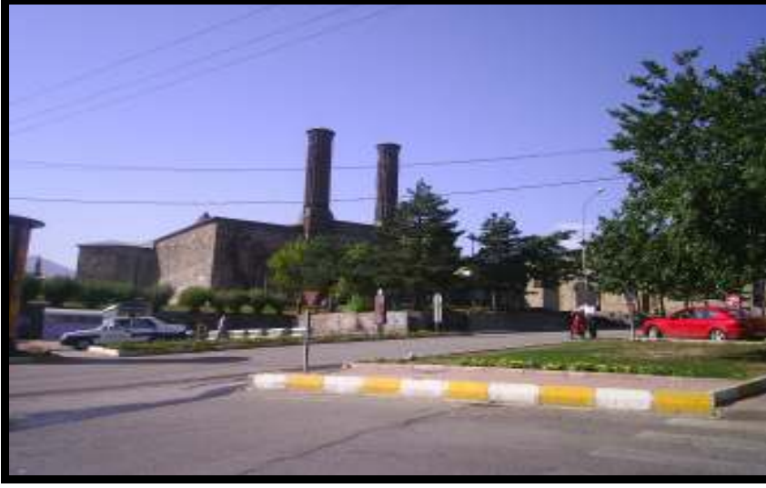
Şekil 4.1. Medresenin Tebrizkapı Caddesinden bir görünümü
