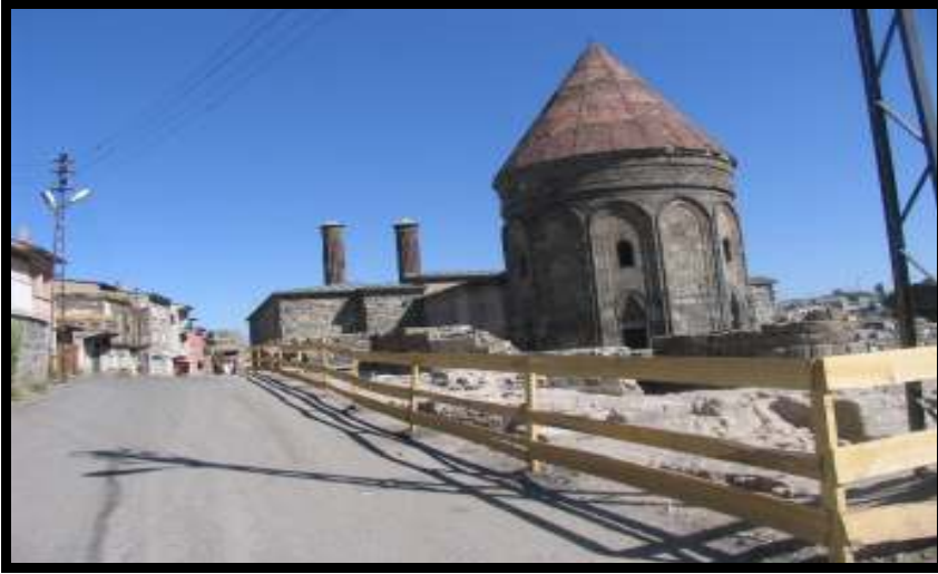
Şekil 4.2. Estetik olmayan kuşatma elemanları ve eski yapılar
