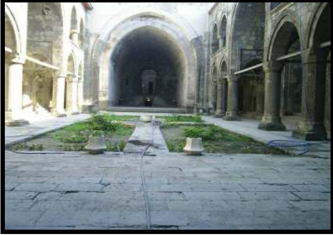
Şekil 3.9. Çifte Minareli Medrese avlu mevcut durum
