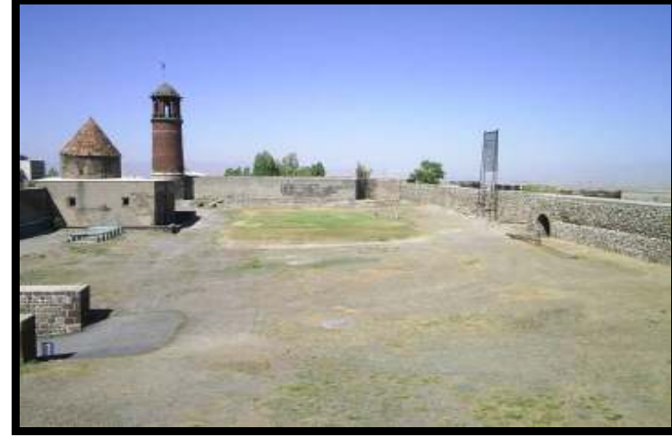
Şekil 3.14. Kale iç avlu mevcut durum
