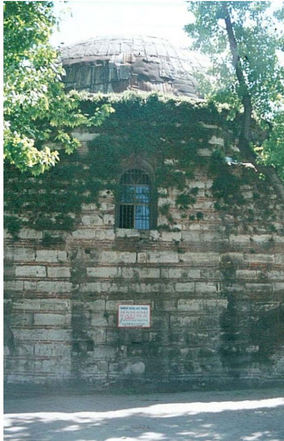
Fotoğraf 5.28 Kılıç Ali Paşa Hamamı’nın duvar örgü tekniği.
