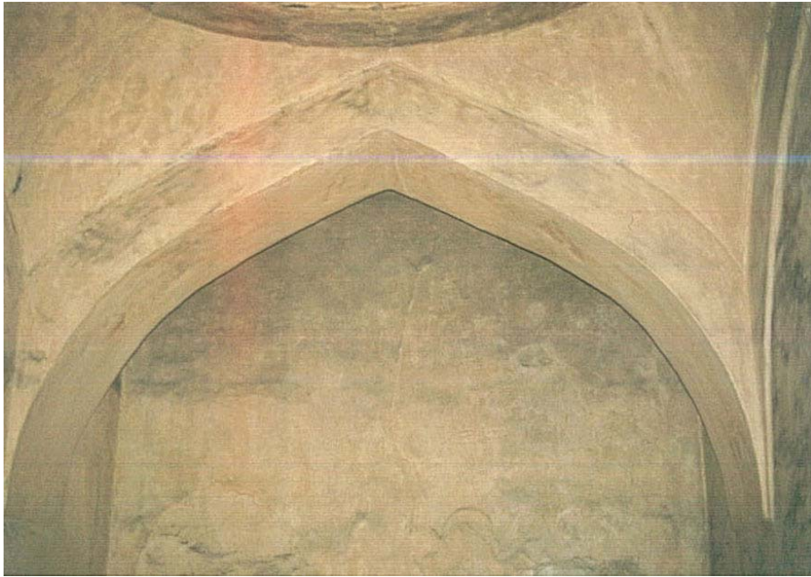
Fotoğraf 3.34. Yeşil Direk Hamamı sıcaklık bölümü kubbesini taşıyan kemer.
