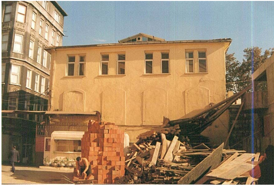
Fotoğraf 3.15. Galatasaray Hamamı arka cephesi.
