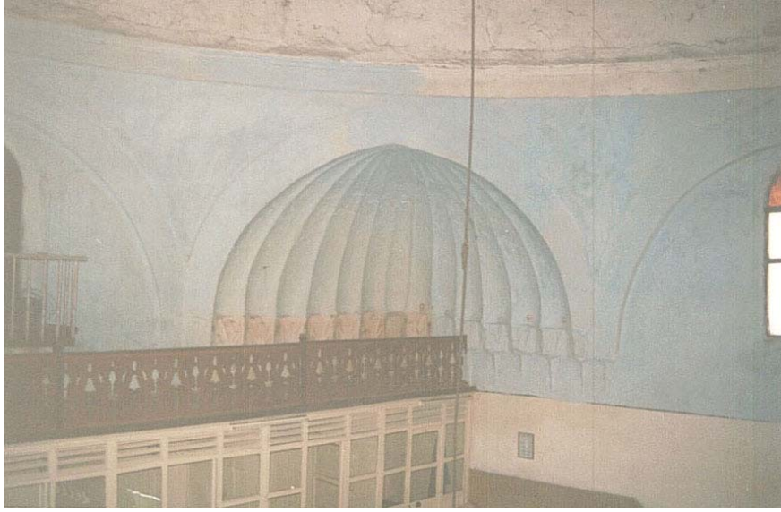
Fotoğraf 5.25 Soyunmalık bölümü kubbe geçiş ögesi.
