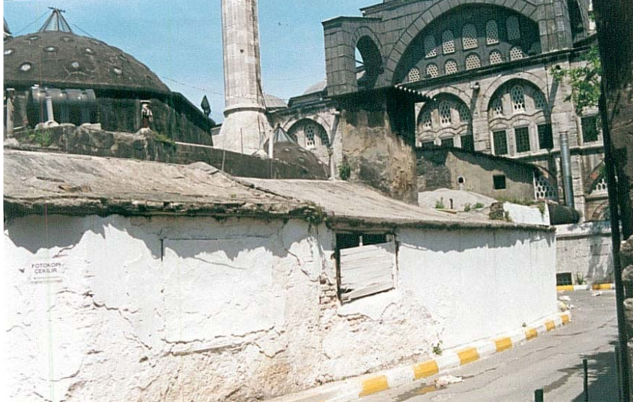
Fotoğraf 5.24 Güney cephesindeki Külhan önüne yapılan ek.
