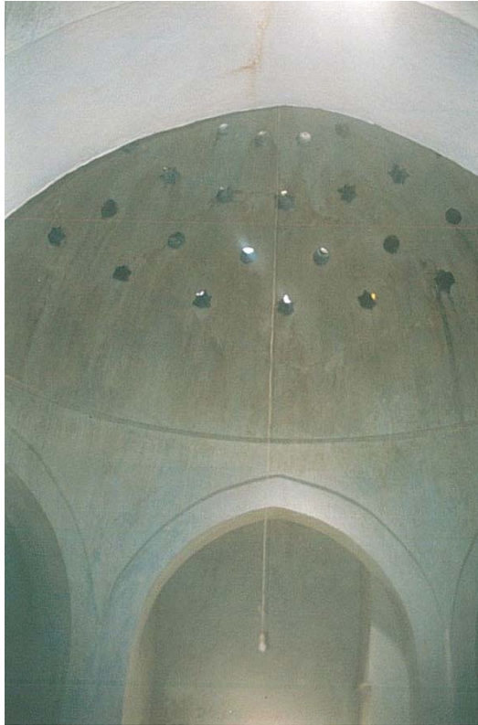
Fotoğraf 5.12 Sıcaklık bölümü kemerleri ve pendentifli kubbesi.
