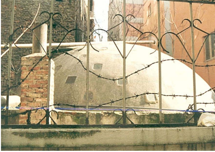
Fotoğraf 3.12. Çukurcuma Sürâhi Hanım Hamamı sıcaklık bölümü ana kubbesi.
