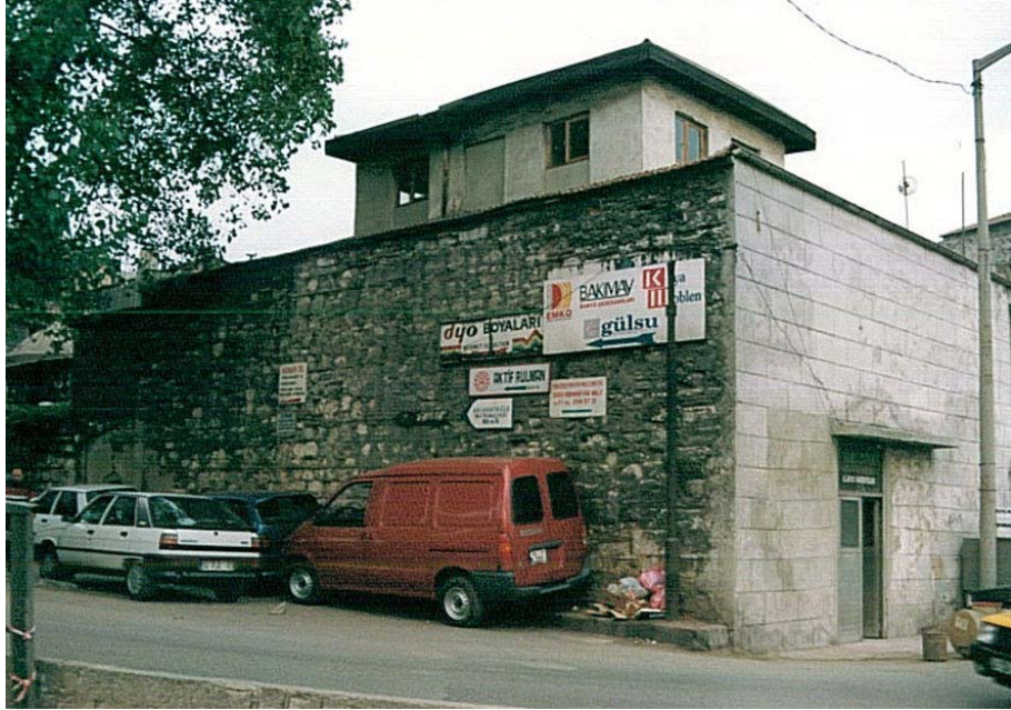
Fotoğraf 3.26. Yeşil Direk Hamamı kadınlar bölümü yan görünüşü.
