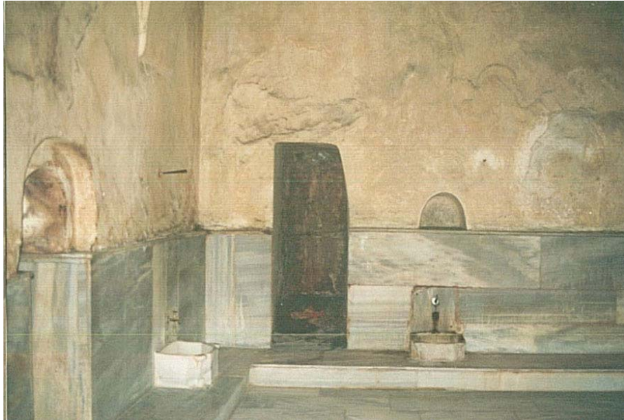
Fotoğraf 3.32. Yeşil Direk Hamamı sıcaklık bölümü ve kapalı olan erkekler bölümü sıcaklığına geçiş kapısı.
