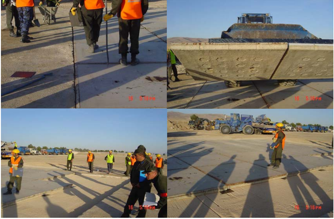
Şekil 2.4 Beton plakaların krater üzerine yerleştirilmesi
