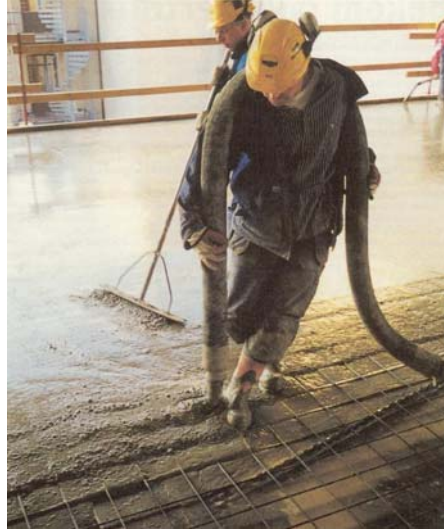
Şekil 5.1. Kendiliğinden yerleşen beton uygulaması
