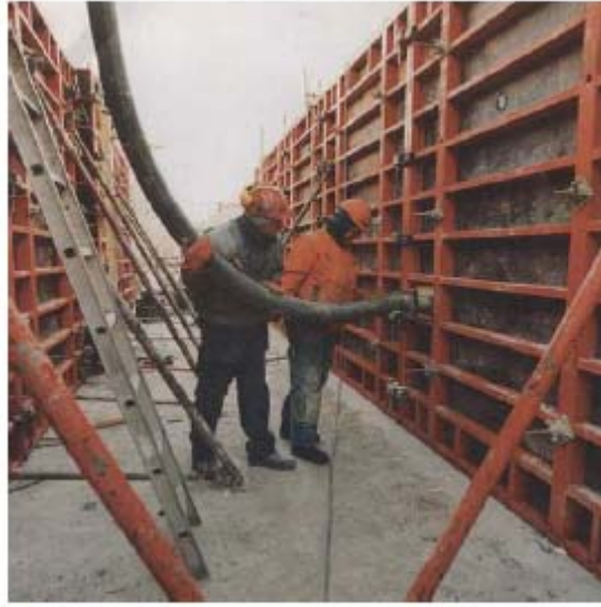
Şekil 5.16. KYB'nin kalıp içine aşağıdan pompalanması
