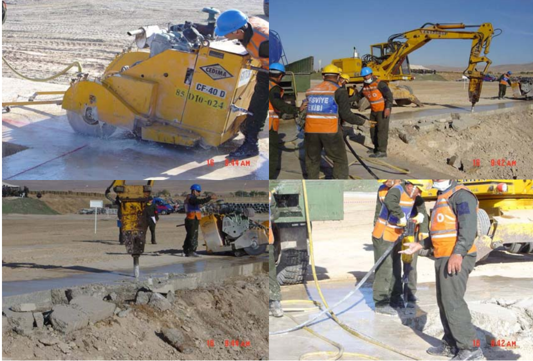
Şekil 2.3 Krater etrafının kesilmesi
