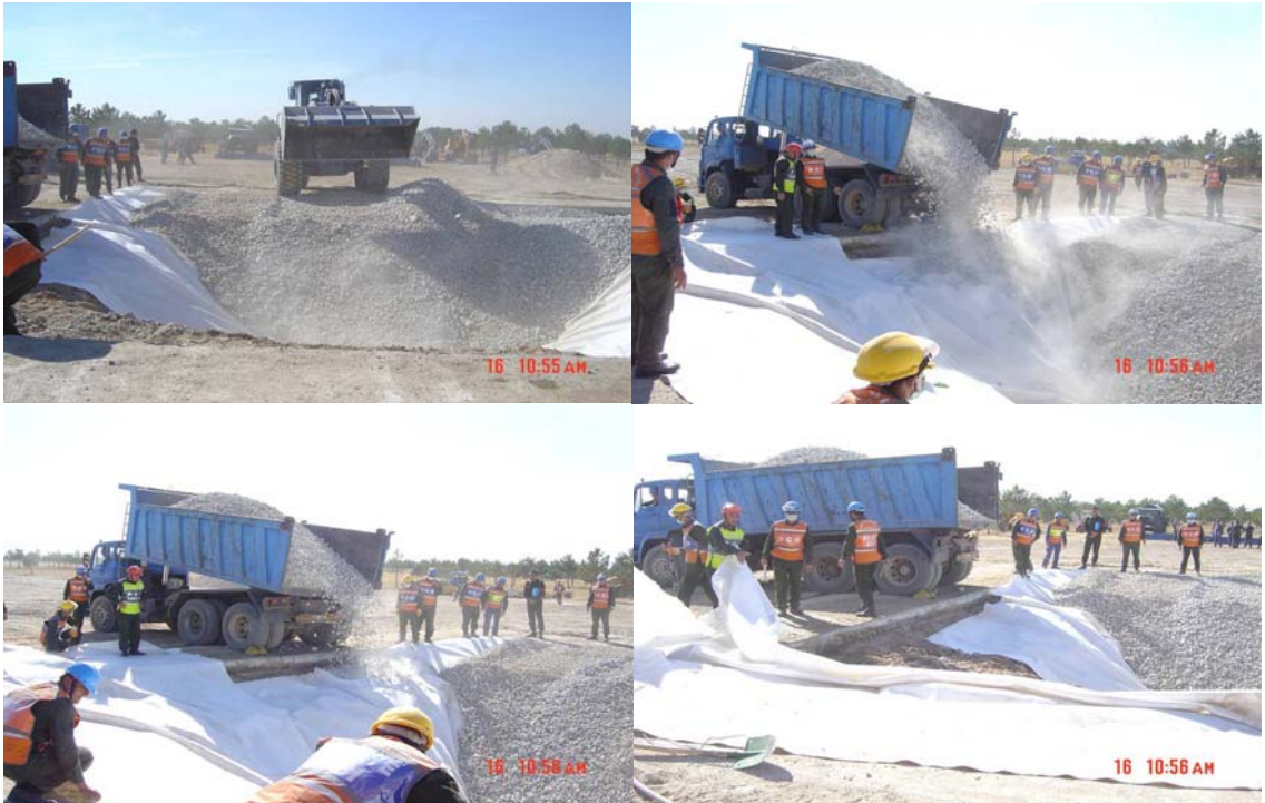
Şekil 2.2 Kraterin kaba ve ince agregayla doldurulması
