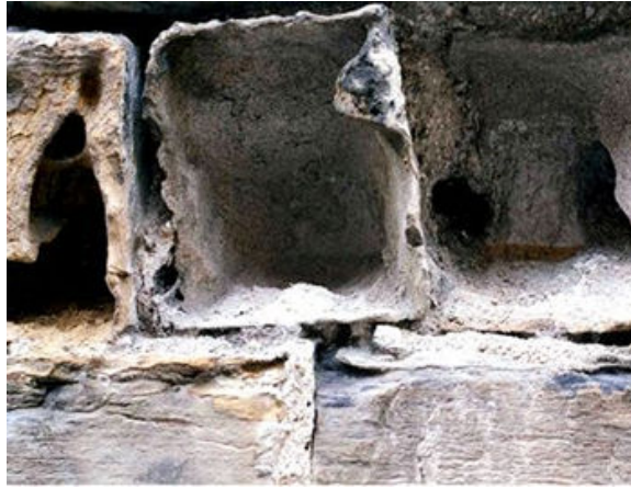
Şekil 2.3. Kumtaşının bozunmasına ait bir örnek, Durham’da bir duvar (Inkpen, 2004)
