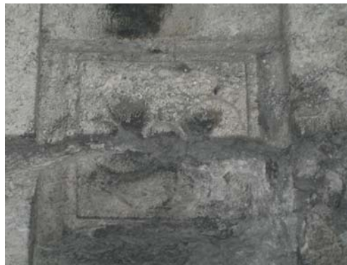
Şekil 5.33. Sütun üzerindeki çiçek süsünde jips oluşumu sonucu ortaya çıkan kararma
