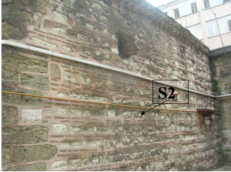
Şekil 5.14. Köprülü Medrese İçi Kapı Girişi Sağ Duvar ve S2 Kodlu Numunenin Alındığı Bölge
