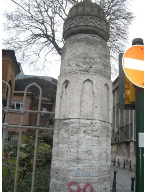
Şekil 5.32. Köprülü Kütüphanesi Bahçe Kapısındaki Sütuna Ait Bir Görünüm
