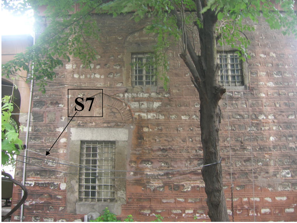
Şekil 5.8. Köprülü Kütüphanesi Güney Cephesi Görünümü ve S7 Kodlu Örneğin Alındığı Bölge
