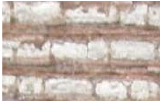
Şekil 5.11. Köprülü Kütüphanesi Kuzey Cephesi S13 Kodlu Numunenin Alındığı Bölge (Kireçtaşı orijinal rengini korumakta)
