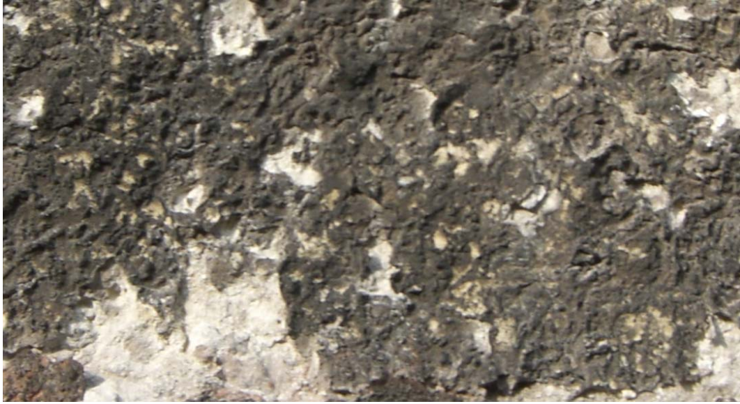
Şekil 5.9. Köprülü Kütüphanesi Güney Cephesi'nde Oluşan Jips Tabakasına ait Örnek (S7 Kodlu Numune)
