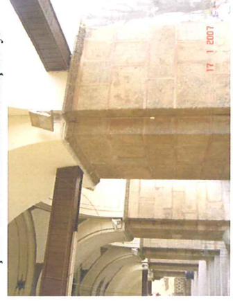
Şekil 4.32 Alt kat mermer korniş detayı
