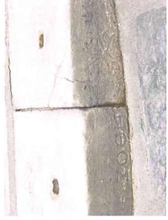
Şekil 4.14 Dış cephe sütunu
