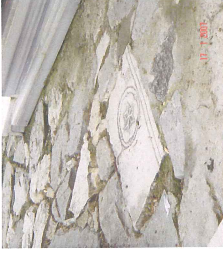
Şekil 4.71 Cami bahçesi avlu taban döşeme taşı
