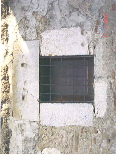
Şekil 4.84 Sol yan cephe penceresi
