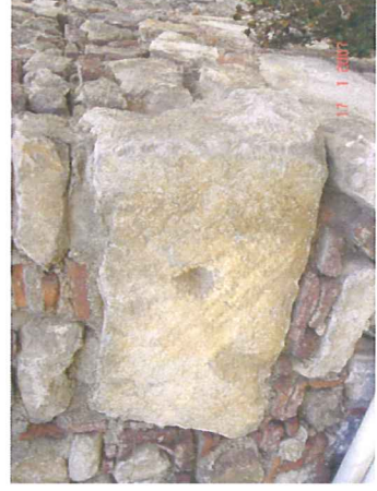
Şekil 4.83 Arka cephe duvarı taş blok detayı
