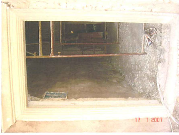
Şekil 4.49 Üst kat iç mekan soldan birinci kapı lento ve sövesi
