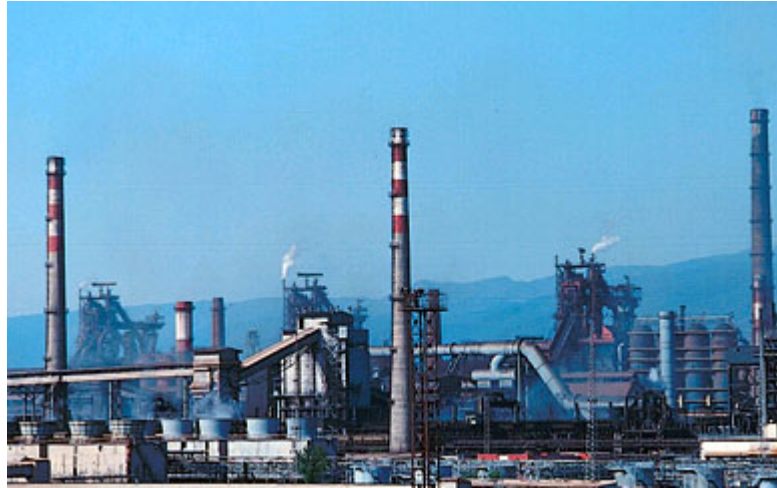
Şekil 3.6. İsdemir tesisleri (İsdemir, 2003)
