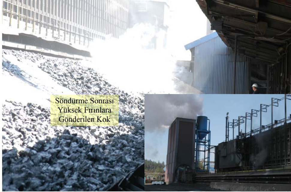
Şekil 4.14. Söndürme kulesi ve söndürülmüş kok
