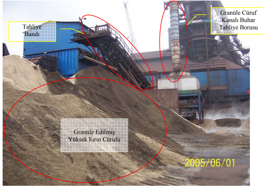
Şekil 4.30. Granüle cüruf sahası
