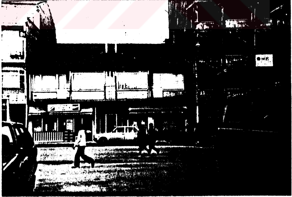
Fotoğraf 10 - Aynı cadde üzerinde,yeni,büyük ve çok katlı binalar arasında sıkışmış ve sonunu bekleyen yapı
