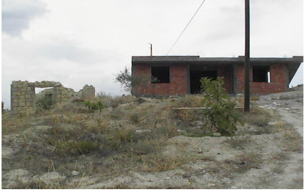
Fotoėraf 3: Eski Tař Yapı Ve Modern Betonarme Yapılar Bir Arada
