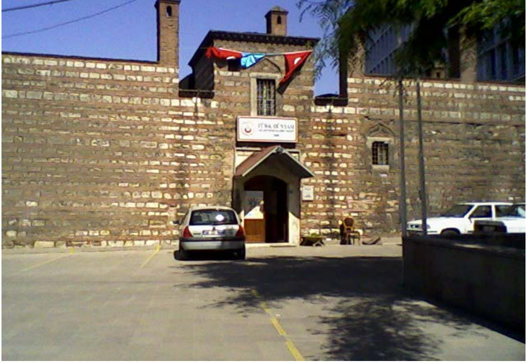
Türk Dünyası Araştırmaları Vakfı Merkezi Dıştan Görünüş
